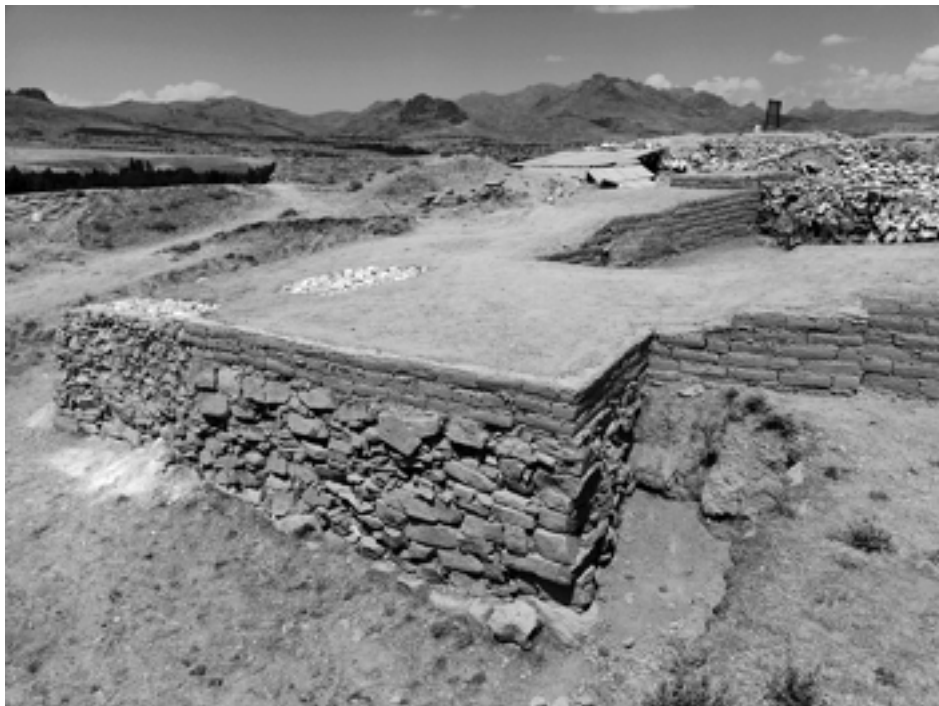
Fig. 9 Travaux de consolidation, Chantier II (Jean-François Pichonneau).
