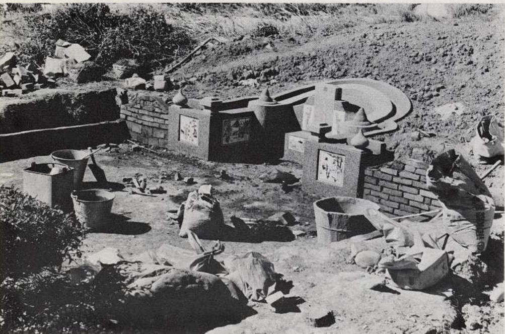
Les tombes de M. Tchang Yuan-liang en construction
