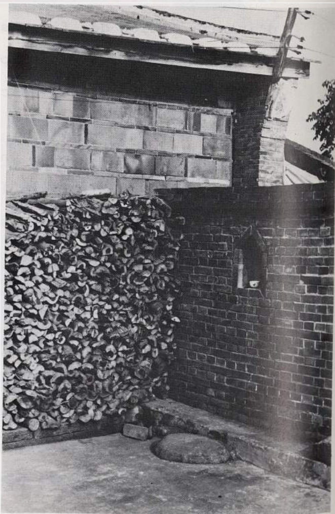
Trou de sortie des eaux
