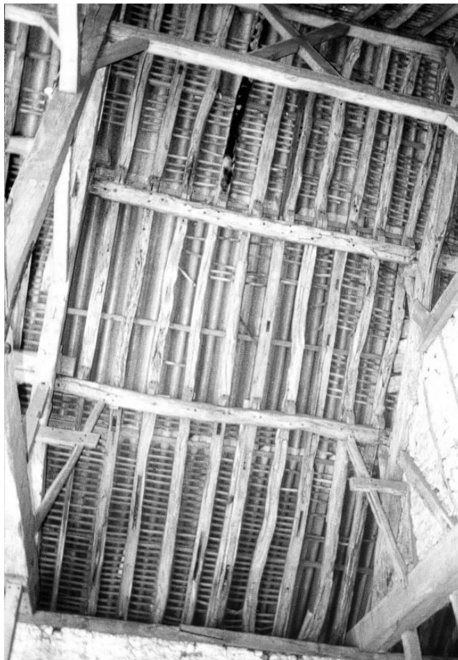
Fig. 18 – Chevrons médiévaux en réemploi (bât. A) –
