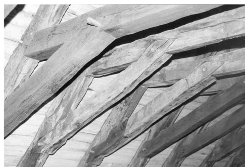
Fig. 21 – Assemblages à mi-bois des aisseliers –
