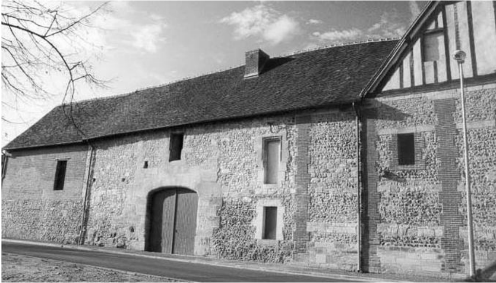
Fig. 6 – Façade de la maladrerie sur la rue du Carmel – (cliché Frédéric Épaul)
