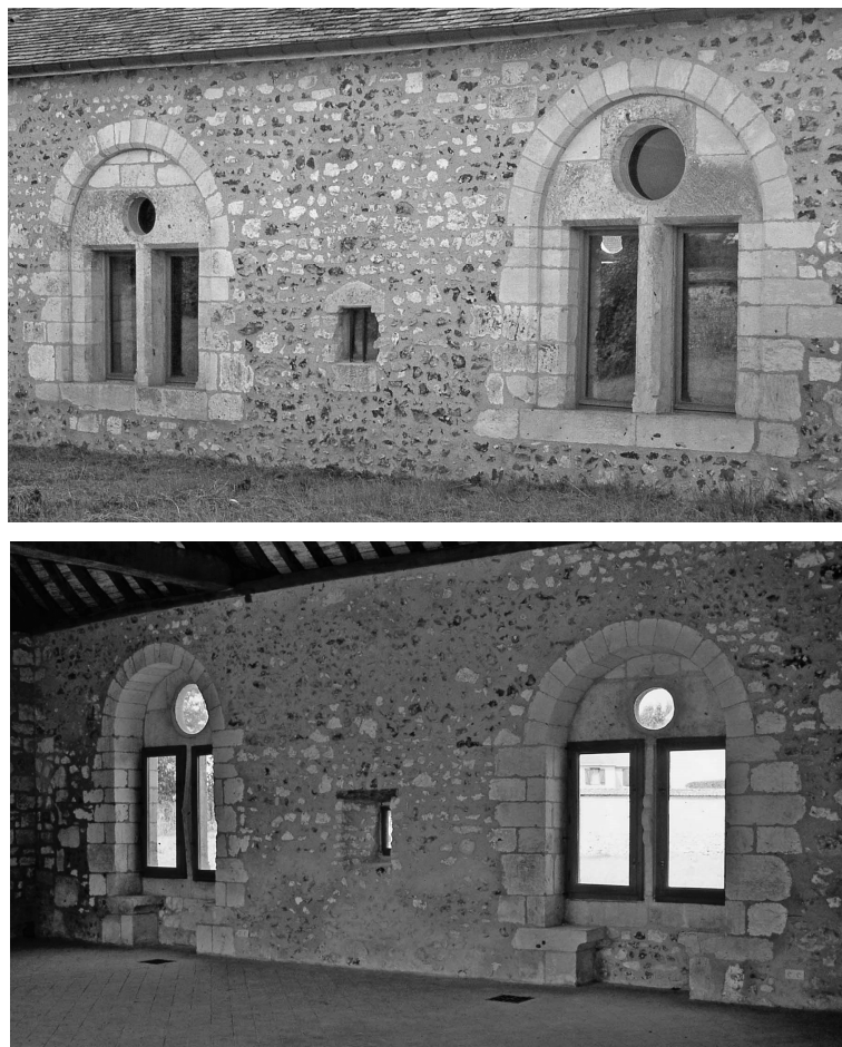
Fig. 15 – Baies romanes de la grande salle –
