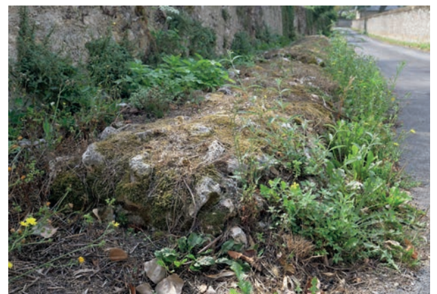
e. Vue générale de l'aqueduc de Truyes
