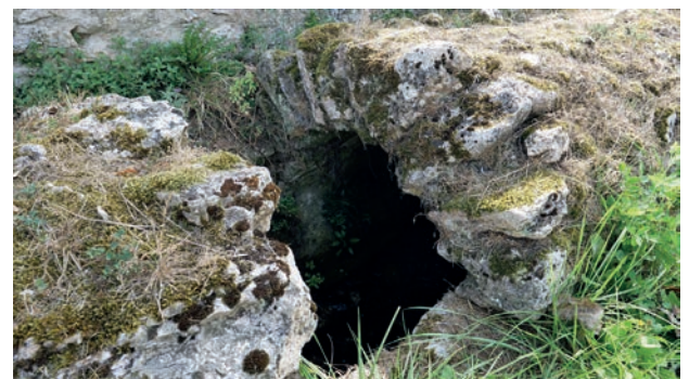
f. Vue détaillée de l'aqueduc de Truyes
