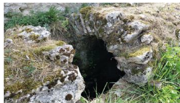
f. Vue détaillée de l'aqueduc de Truyes
