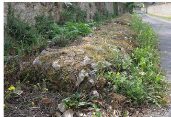
e. Vue générale de l'aqueduc de Truyes
