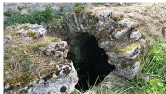
f. Vue détaillée de l'aqueduc de Truyes
