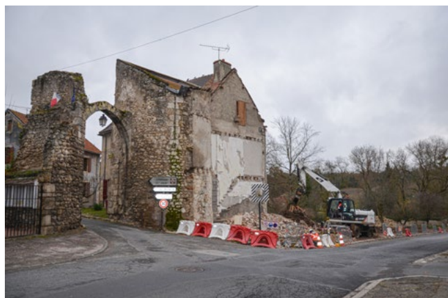
Figure 1 : La porte Chabotin et le diagnostic en cours de réalisation
