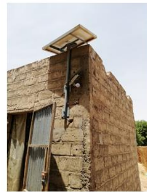
SHS installé chez un ménage dans le village de Darou Djaji Guéyène, exploité par NSRESIF
