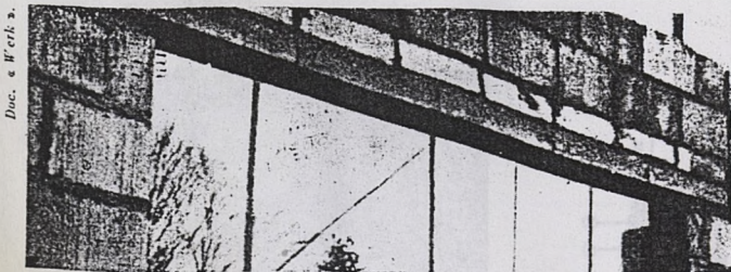
Linteau de fenêtre préfabriqué en terre cuite armée (Suisse).
