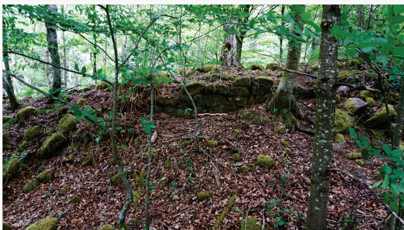
Figure 157 : Vue vers l'est du parement du rempart interne (tronçon nord) (Cliché : S. Gentner, Mai 2020)
