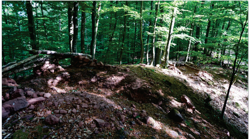
Figure 179 : Vue des guérites creusées dans le tronçon est du talus (vue intra-muros , vers le sud-est) (Cliché : S. Gentner, Mai 2020)
