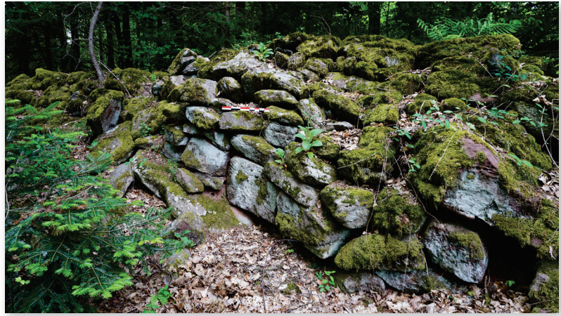
Figure 98 : Vue vers le nord du parement interne du tronçon est du rempart (Cliché : S. Gentner, Mai 2020)
