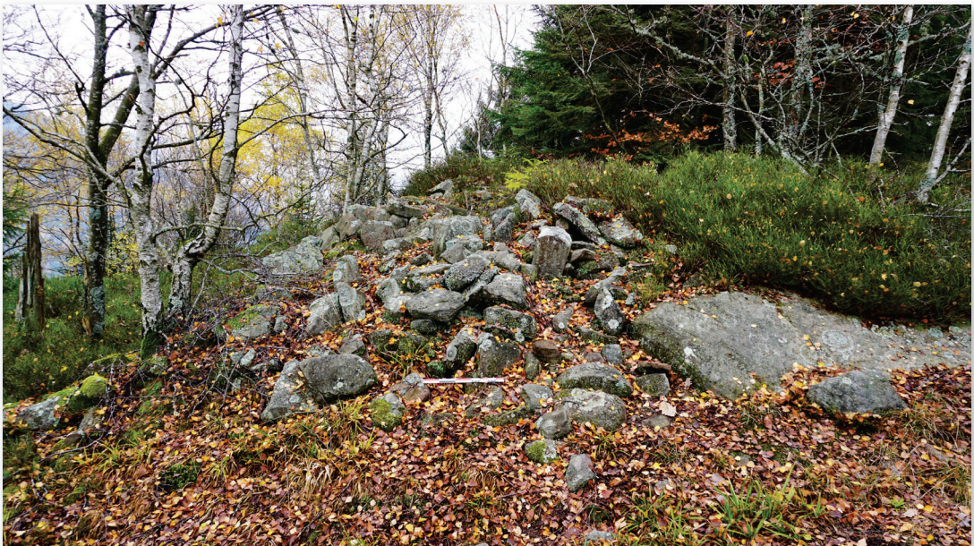
Figure 49 : Vue vers l'est de la conservation actuelle du rempart (Cliché : S. Gentner, Novembre 2019)
