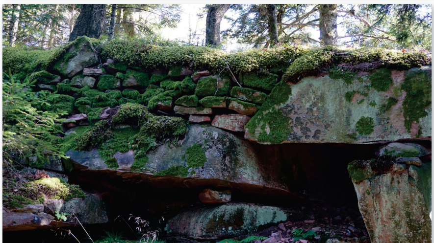
Figure 133 : Détail du mur supérieur, intégrant les dalles géologiques dans son architecture (Cliché : S. Gentner, Août 2020)
