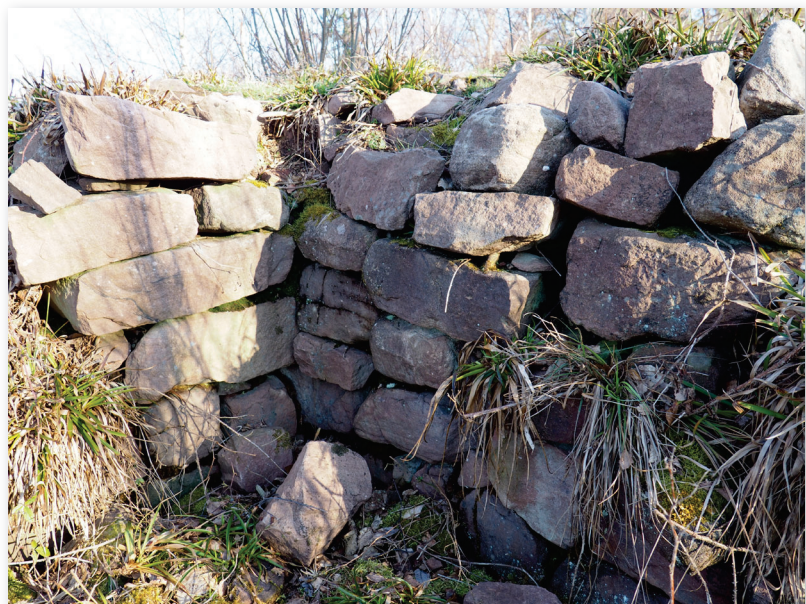
Figure 83 : Vue de l'angle interne sud-est de l'édifice central (Cliché : F. Minot, Mai 2020)
