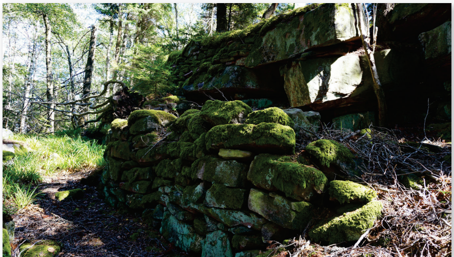
Figure 132 : Vue vers le nord, des tronçons de mur visibles au sud-ouest du site (Cliché : S. Gentner, Août 2020)
