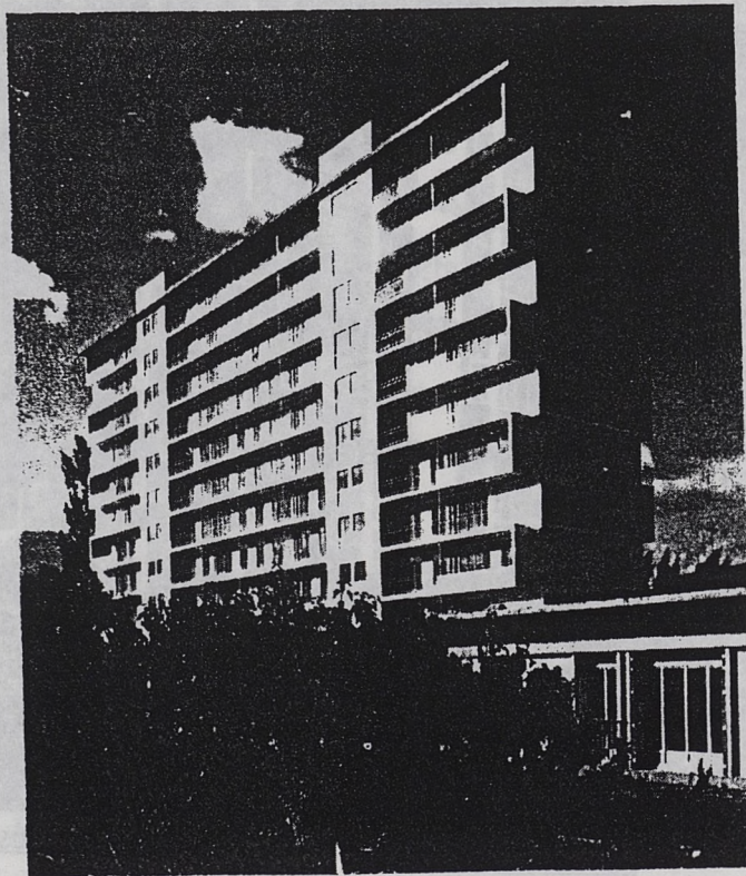
E.Beaudoin, 800 logements à Sceaux
