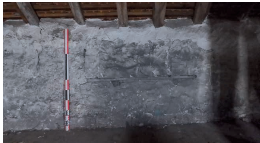
Fig. 71 Vue de l'une des trois anciennes ouvertures à présent murées et dont l'appui correspond au bois horizontal. Cliché : N. Warmé, Inrap
