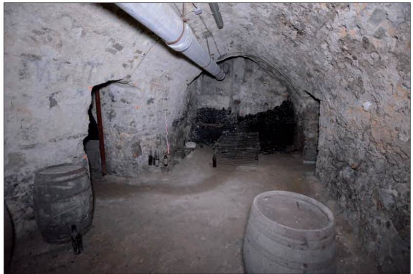
Fig. 95 Vue vers le nord-ouest du grand volume rectangulaire central. Cliché : N. Warmé, Inrap
