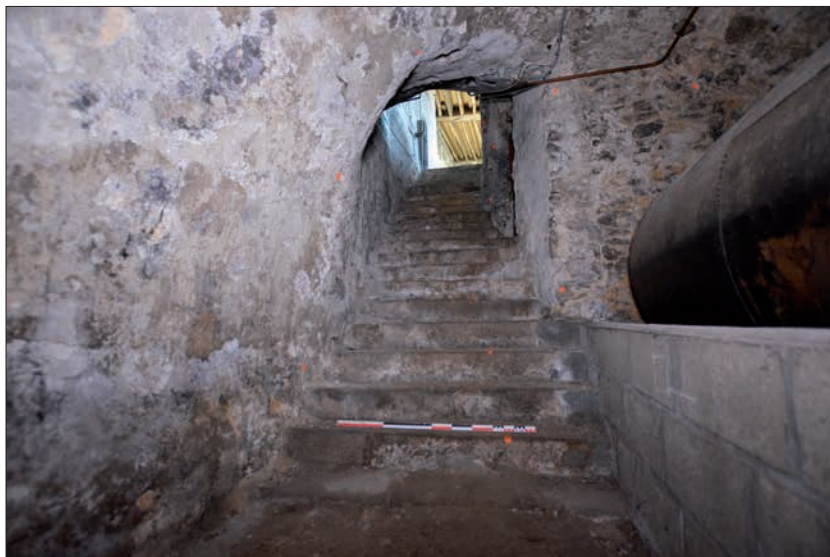
Fig. 96 Vue vers le nord-ouest du grand escalier droit d'accès (accès actuel). Cliché : N. Warmé, Inrap
