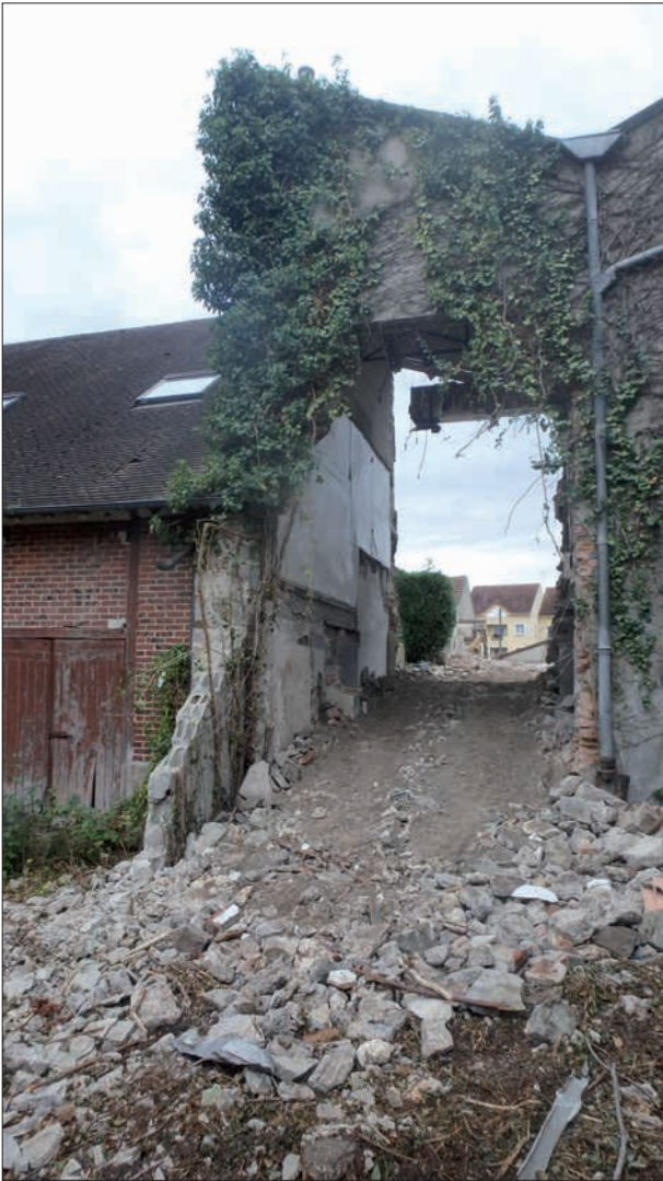
Fig. 6 Vue depuis la parcelle 70 de la rampe d'accès au travers l'ancien abattoir. Cliché : N. Warmé, Inrap
