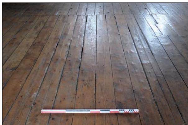
Fig. 69 Détail des lames de parquet. Cliché : N. Warmé, Inrap
