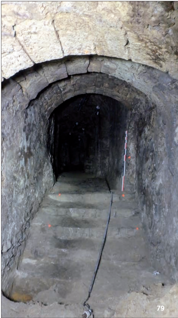
Fig. 79 Vue des 5 marches en grès à la jonction des parties A et B. Cliché : N. Warmé, Inrap
