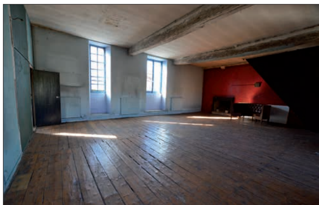
Fig. 68 Vue générale de la grande pièce à l'étage avec son parquet en sapin. Cliché : N. Warmé, Inrap
