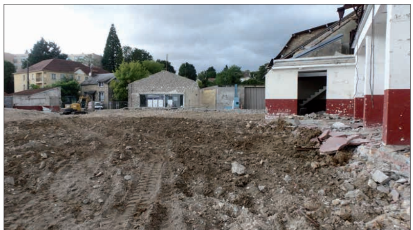
Fig. 8 Vue d'une partie de la parcelle 81 après les démolitions. Cliché : N. Warmé, Inrap
