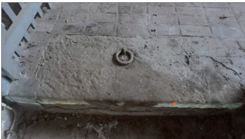
Fig. 97 Vue de l'anneau situé en haut de l'escalier. Cliché : N. Warmé, Inrap
