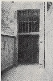
L'accès à la cave recouvert de gravillons. →
