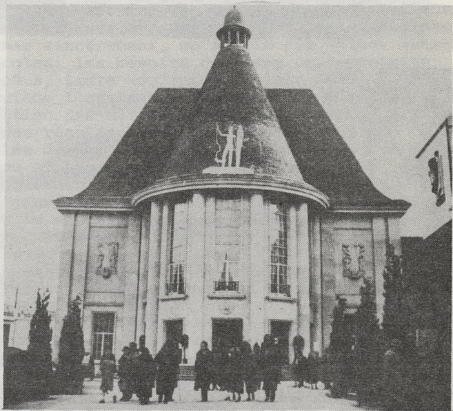
93. CASTEL, ROZAN, ALLAR, GENSOLLEN - Pavillon Marseille-Provence
