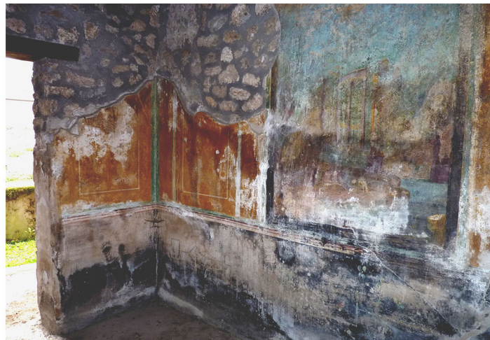
Fig. 7. Détail de l'angle nord-ouest de la pièce (14).
