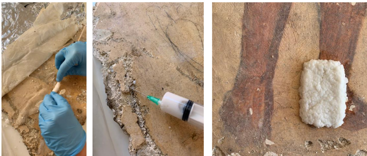
Fig. 21. Rimozione della velinatura protettiva, consolidamenti puntuali e prove di pulitura.
