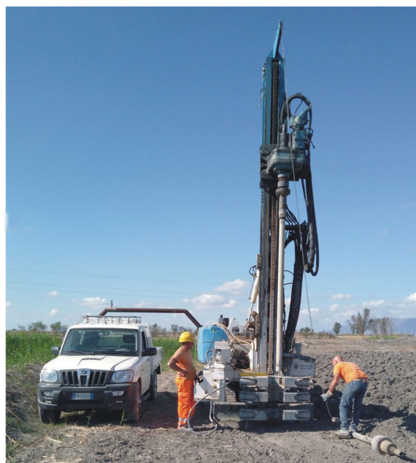
Fig. 5. Arpi, campagne de carottages en cours (© DiSPaC UniSa, photo V. Amato).
