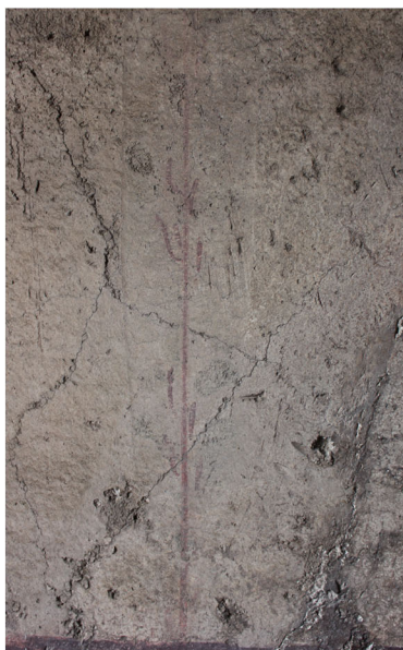
Fig. 5. Caupona della via di Mercurio (VI 10, 1), paroi sud de la pièce d, empreinte d'une règle pour le positionnement de la tige végétale (photo L. Guida).
