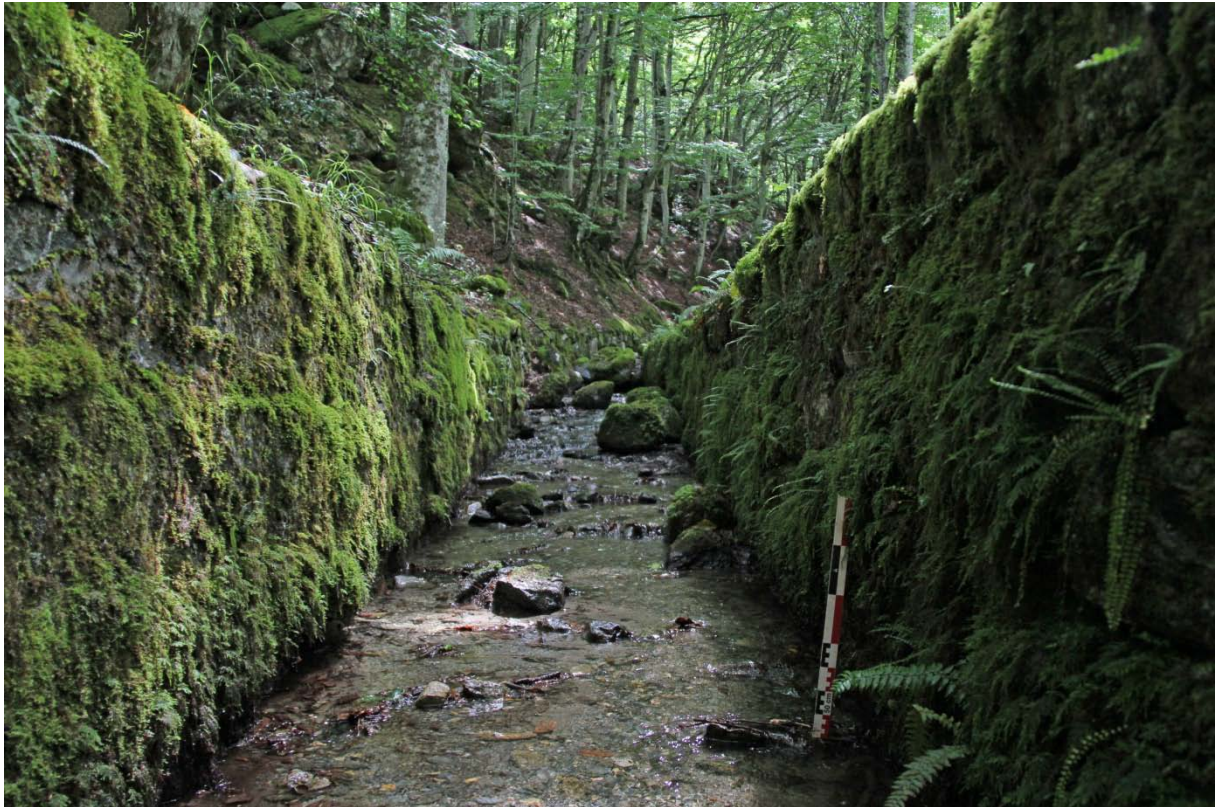
Figure 4 : Canal d'amenée d'eau de la forge d'Orlu ; vue vers l'amont
