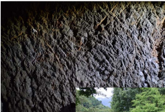
Traces d'outils sur les parois de la mine de Laybagos 01
