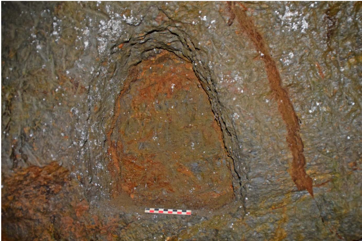
Figure 13 : Cliché de la niche ménagée sur la paroi sud de la galerie de Laybagos 01
