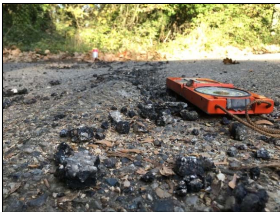
Figure CG5 : Deux exemples d'indices de ruptures de surface associés au seisme du Teil du 11-11-2019 cartographiés par l'équipe tectonique active (J-F Ritz, S. Baize, M. Ferry, C. Larroque et L. Audin): [en haut] plis et fissures en échelons affectant la route (ph. J-F Ritz) ; [en bas à gauche] : détails de l'indice présenté en haut, montrant le plissement de la chaussée et son soulèvement dans la partie SE coté boussole (ph. J-F Ritz) ; [en bas à droite] : chemin de terre recoupé par la rupture avec soulèvement de la partie SE où se trouve la personne (ph. S. Baize).
