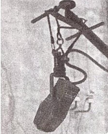
Ill. 8 : Microphone RCA 44 BX (détail). La capsule bidirectionnelle est dirigée vers le bas en direction des acteurs (Photo ©MPC)
