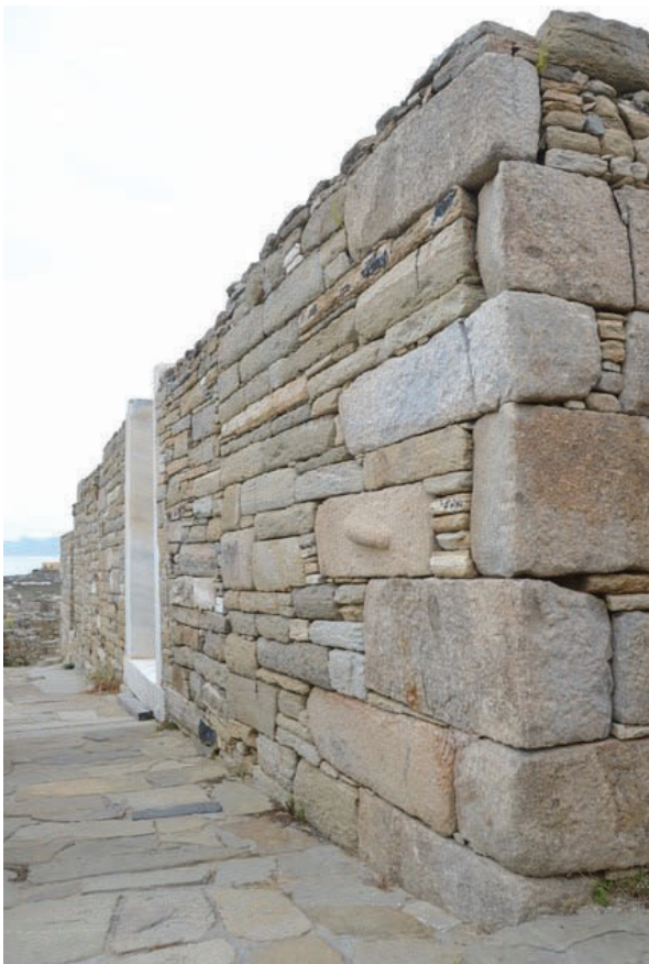
Un mur d'une maison antique combinant du granite local (chainage d'angle), du gneiss (matériau principal du parement en partie au moins importé) et du marbre importé (encadrement de la porte) (photo : EFA, J.-Ch. Moretti).
