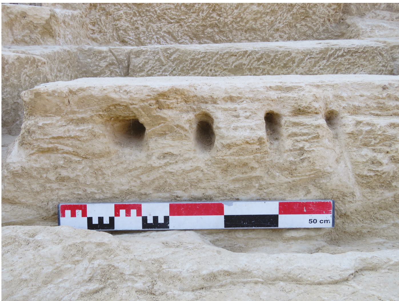
Fig. 6 : Détail d'emboîtures du V e siècle sur un bloc mal venu (cliché Ph. Mellinand, Inrap)
