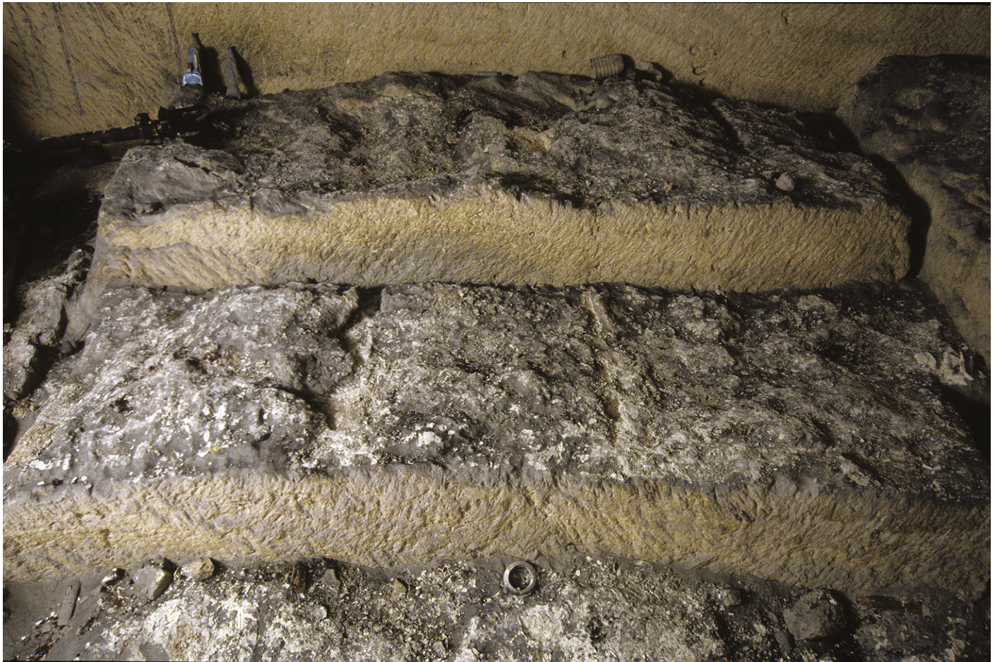
Fig. 6 : Calcaire blanc de Saint-Victor. Traces d'extraction antiques situées au niveau des sols profonds de la crypte de l'abbaye. Pour les prélèvements répertoriés voir le tableau n° 1 (cliché L. Damelet, CNRS, CCJ)
