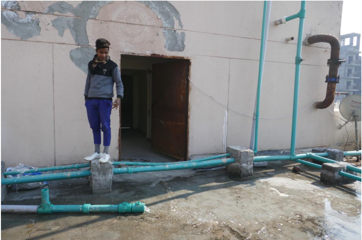
Photo 6 : Détérioration rapide des conduites d'eau (sur le toit du projet résidentiel Adore)
