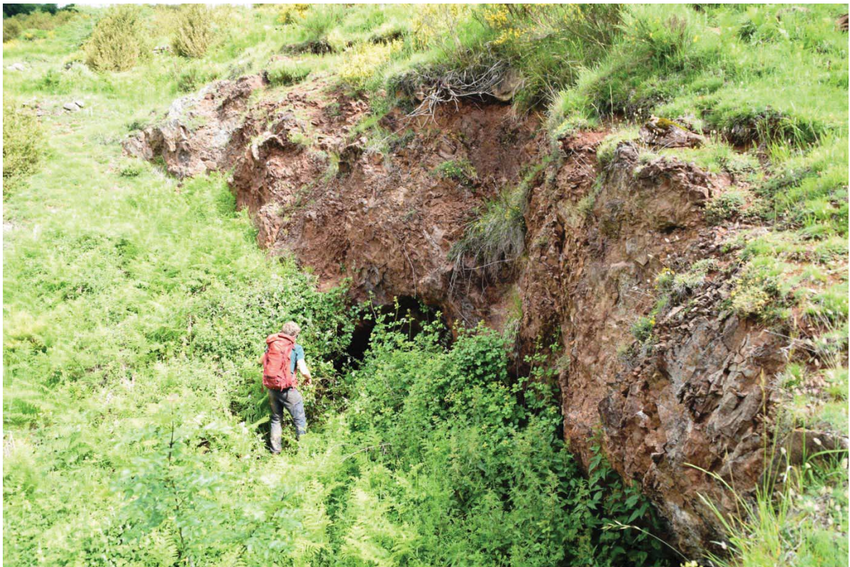
Figure 24 : Vue générale du chantier à ciel ouvert de Bouichette 03
