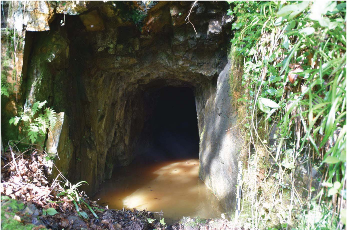
Figure 38 : Débouché de la galerie de Labadas 01
