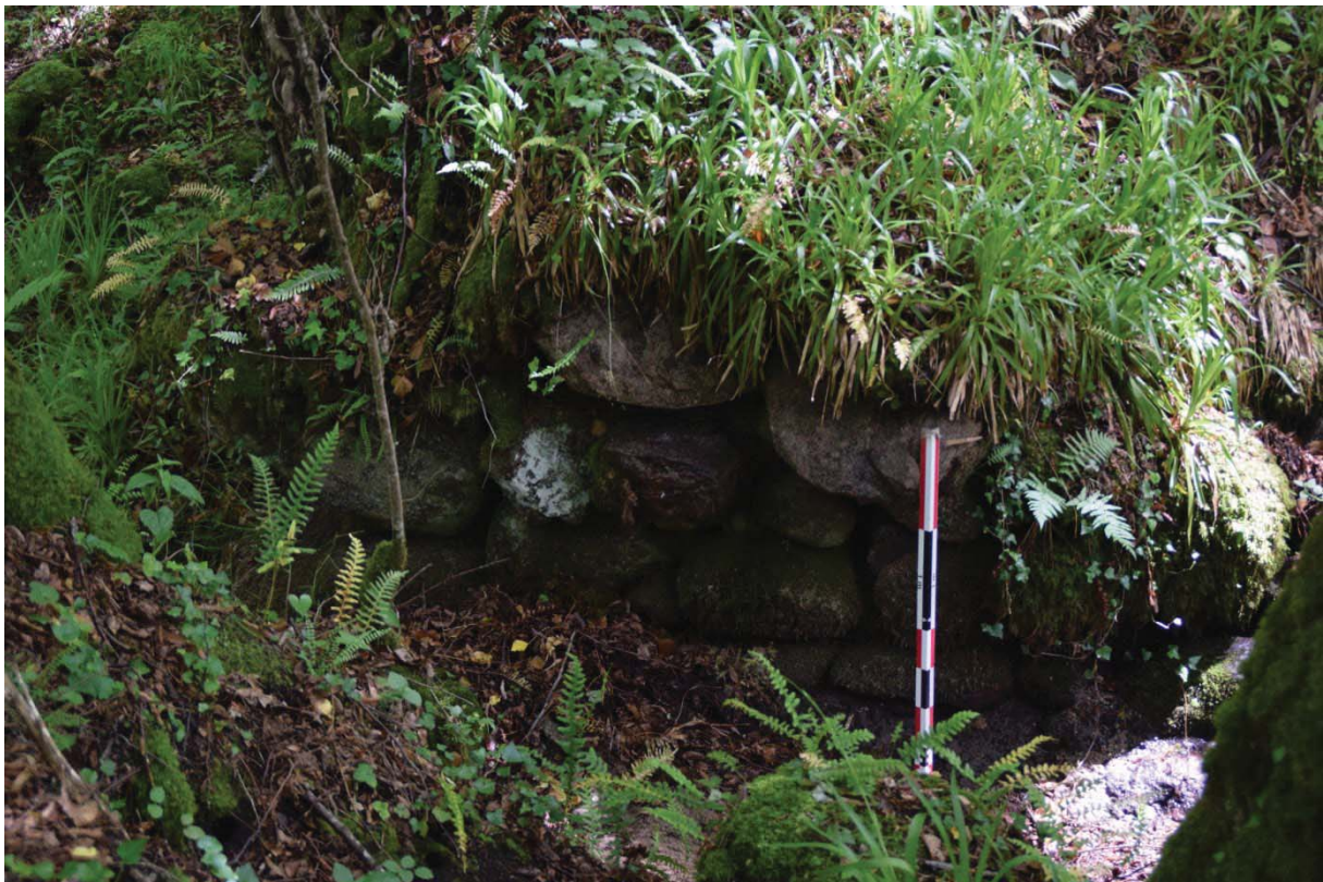
Figure 26 : Parement sud du canal d'amenée de la forge de Sigueille 01
