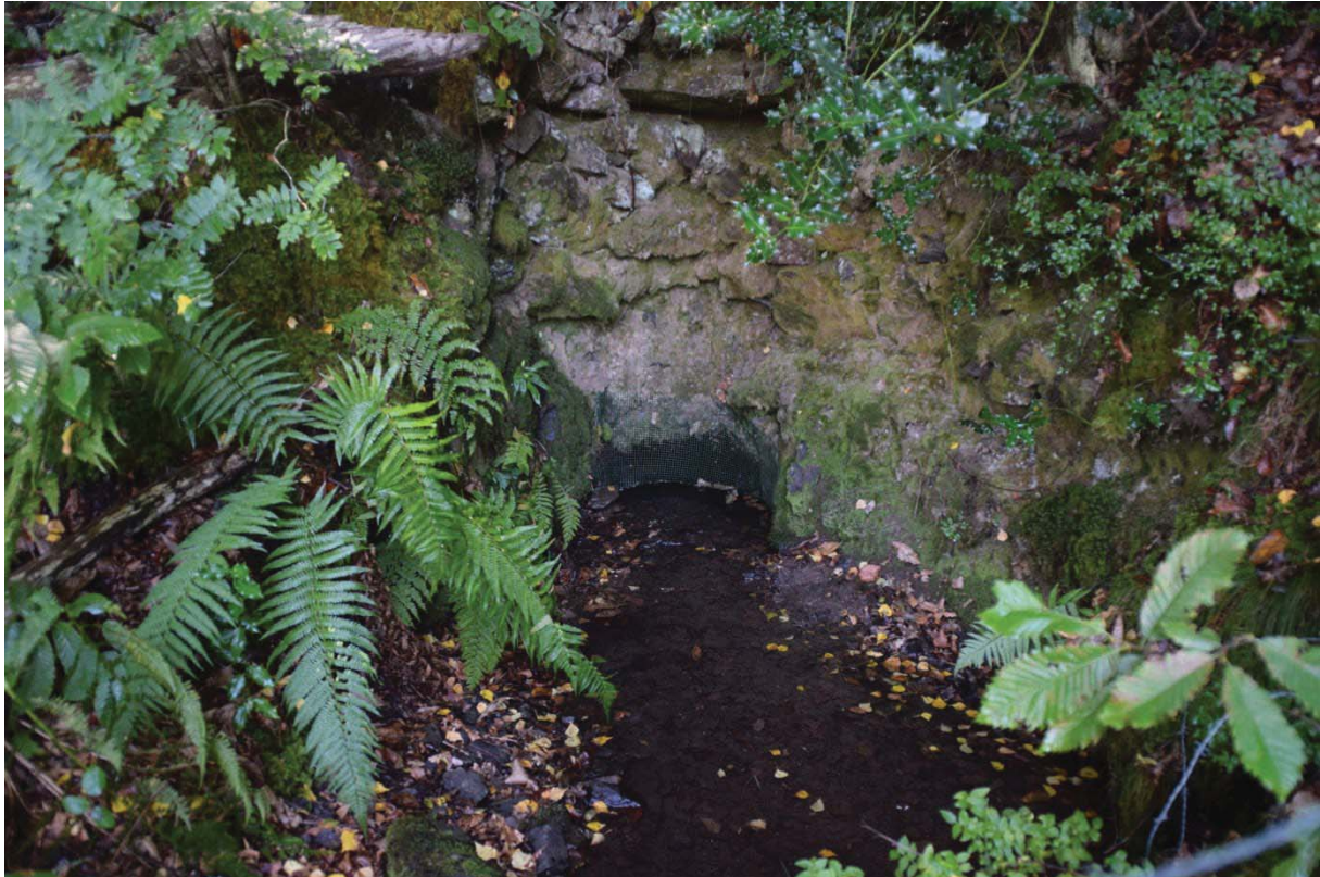
Figure 33 : Débouché de la galerie de Bezole 01 ; celle-ci est presque totalement inondée
