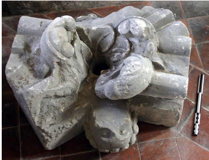
Fig. 13 - Clé de voûte déposée de la première travée du haut vaisseau (inv. 16).
