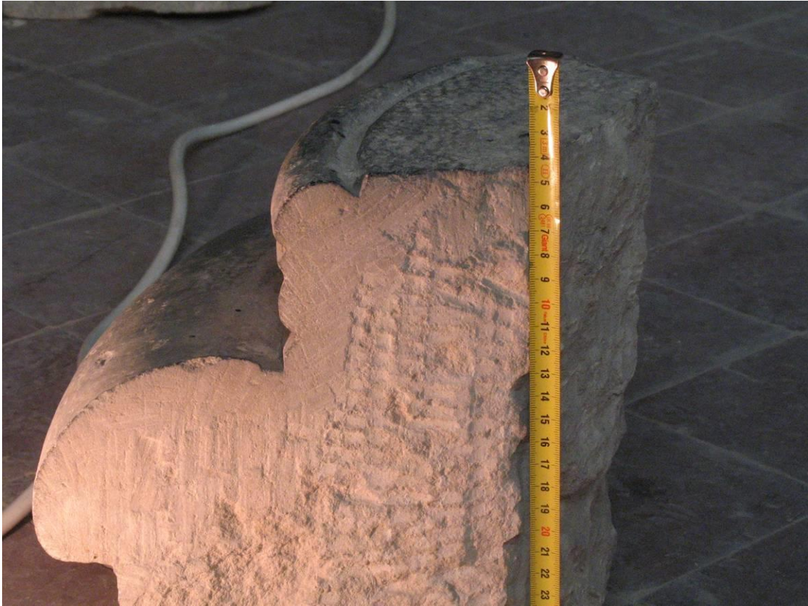
Fig. 20 - Face de liaisonnement latérale d'une base (inv. 58, cf. fig. 4) montrant une taille périphérique.
