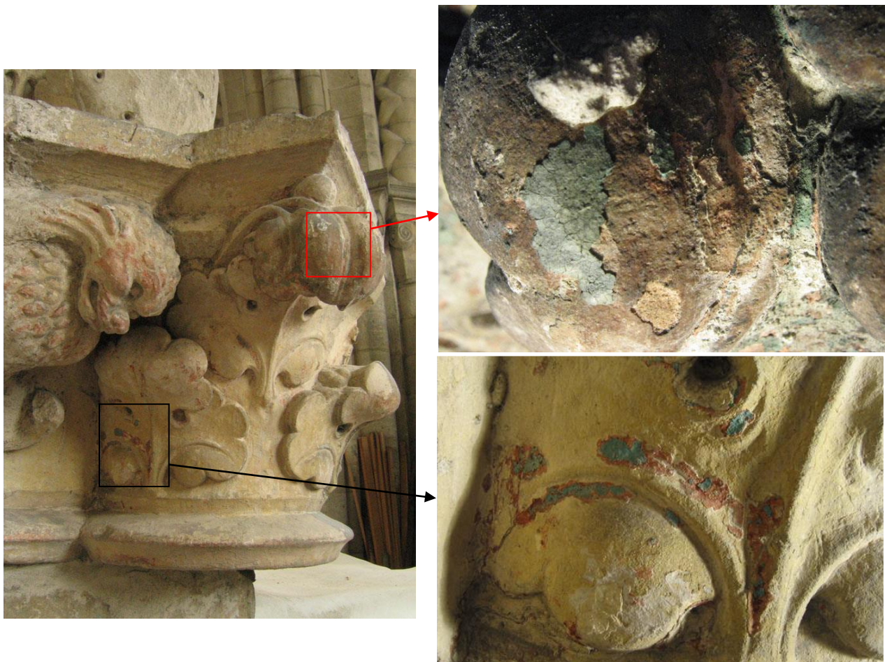
Fig. 22 - Deuxième chapiteau nord déposé (inv. 13) et vestiges de polychromie. En haut à droite, craquelures vraisemblablement dues à la présence d'un liant à l'huile.
