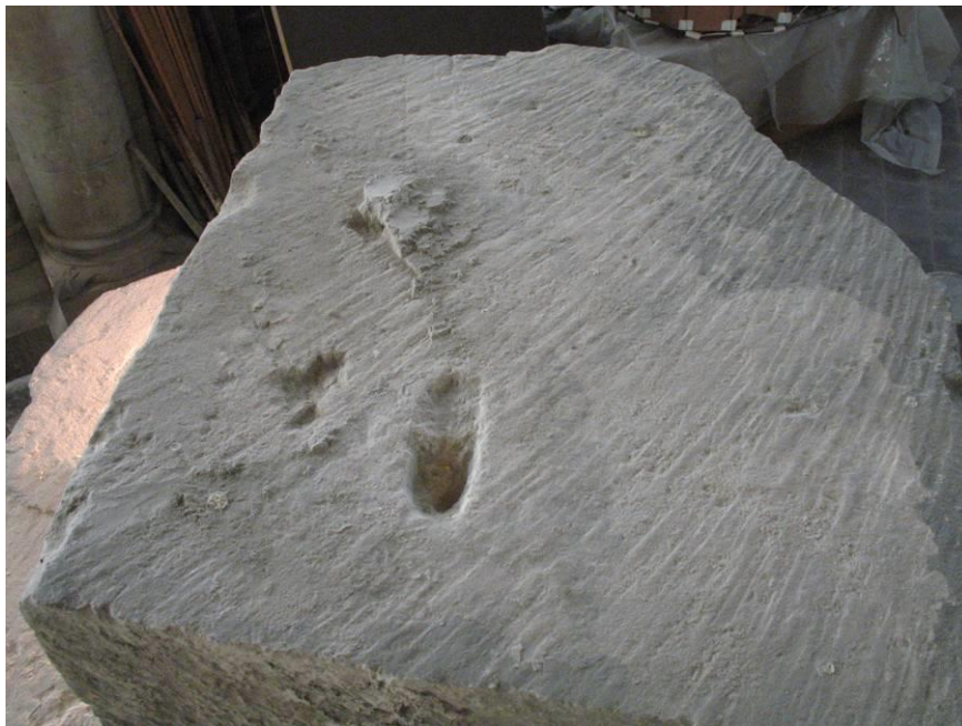
Fig. 18 - Layage régulier au taillant droit sur le lit d'attente d'une pièce du chapiteau 4N (inv. 147, cf. fig. 11).
