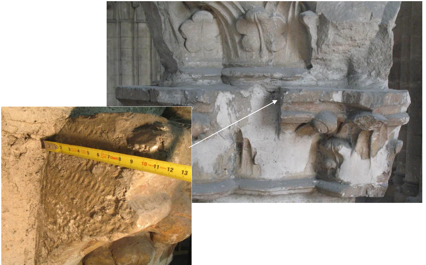
Fig. 15 - Face de liaisonnement latéral d'un fragment du troisième chapiteau nord, layé avec une gradine (inv. 127).
