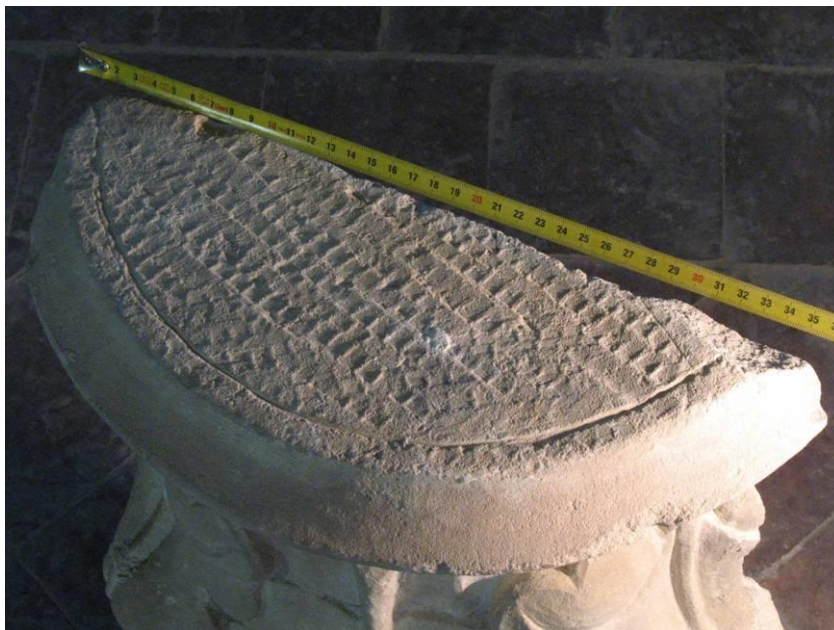
Fig. 18 - Layage régulier au taillant droit sur le lit d'attente d'une pièce du chapiteau 4N (inv. 147, cf. fig. 11).
