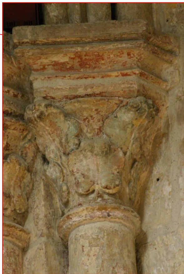
Fig. 28 - Bas-côté nord de la nef, chapiteau de la pile engagée en regard de la troisième pile nord de la nef.
