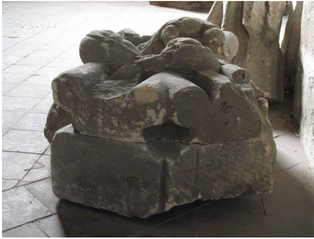
Fig. 17 - Détail des départs d'ogives de la clé et schéma d'emplacement des marques de pose (inv. 16).
