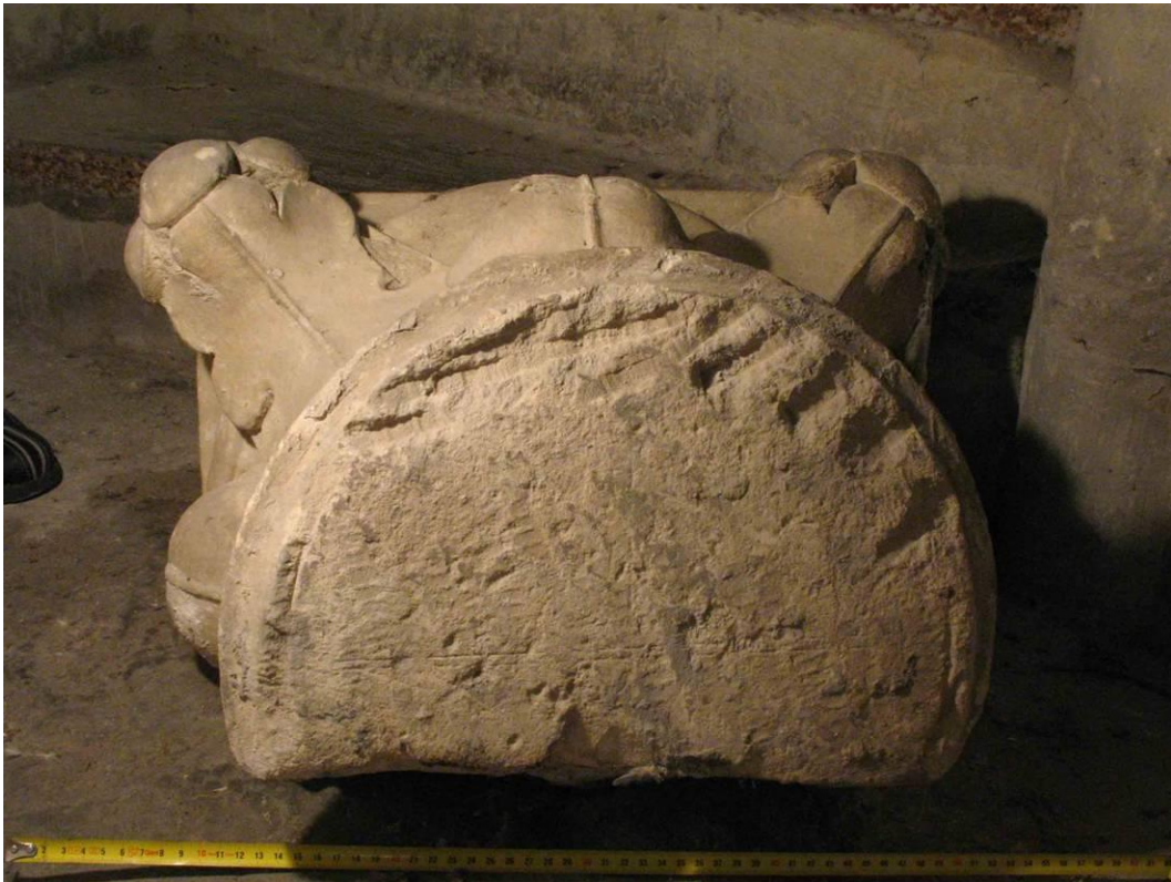
Fig. 16 - Les épures sous l'astragale d'un fragment du premier chapiteau sud (inv. 90) : cercle et diamètres perpendiculaires.
