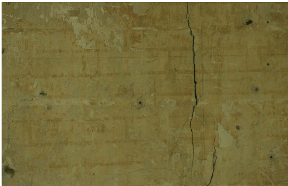
Fig.7 : Noyon, cathédrale, détail du mur occidental de la tribune sud : les joints bruns du deuxième décor. Cl. G. Victoir.
