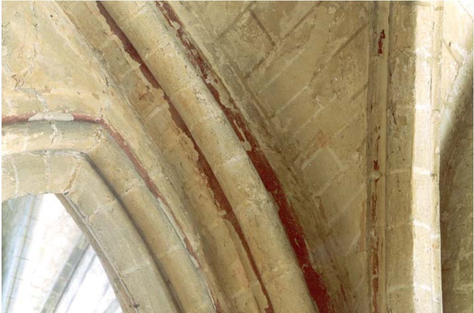
Fig.4 : Noyon, cathédrale, premier décor de joints blancs sur la voûte de la première travée de la tribune sud. Les joints bruns appartiennent à un décor post-médiéval et le rouge des gorges au troisième décor (états C et D). Cl. G. Victoir.
