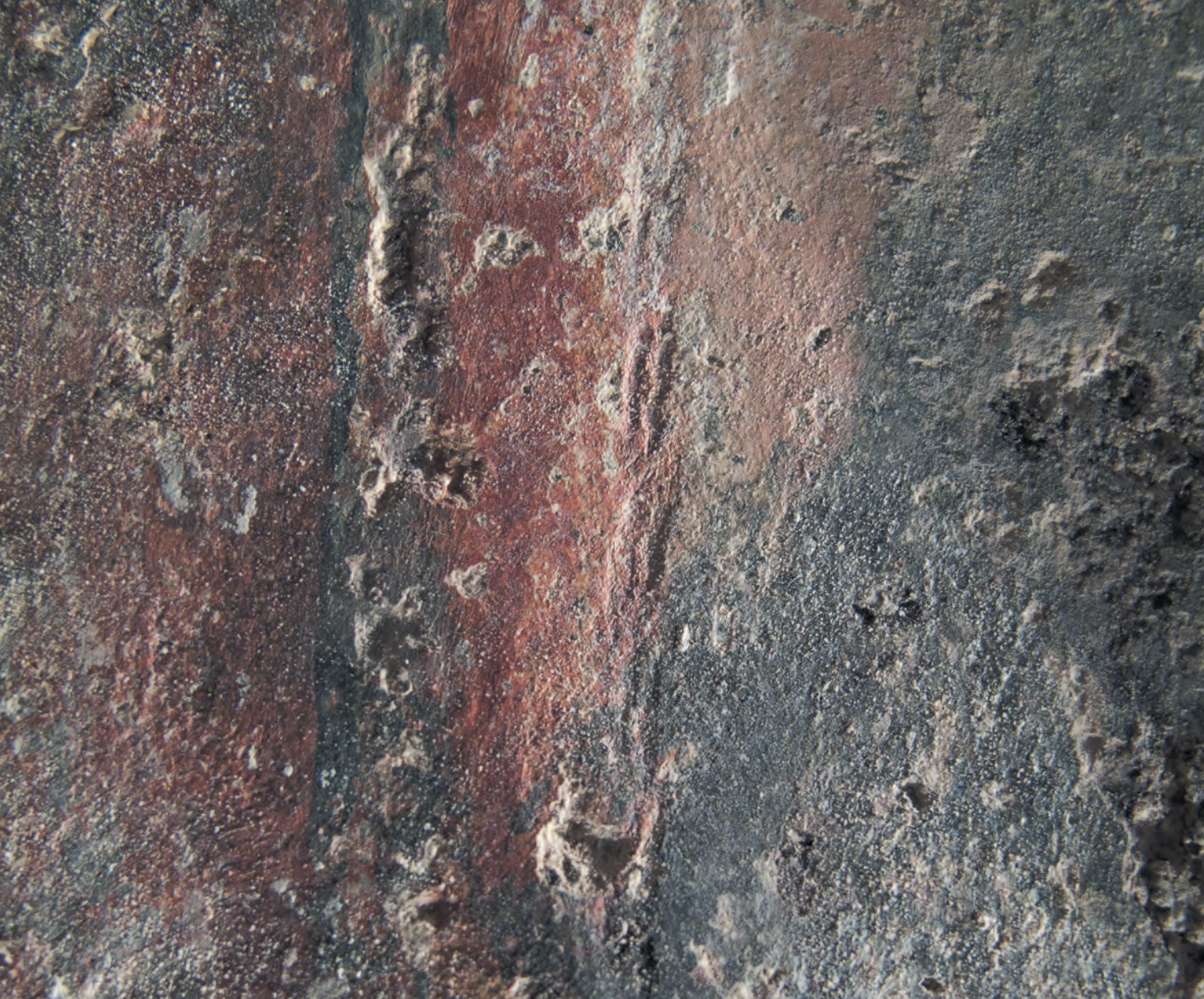
Fig. 9 : Église de Saint-Martin-des-Puits, chœur (mur est) : marque de fil battu sur enduit frais. Droits de reproduction : O. Guillon — CICRP.
