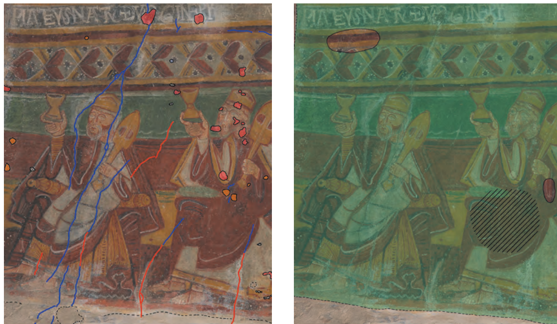
Fig. 7. — Cartographies de la partie orientale du 3 e registre-paroi sud à Saint-Martin-de-Fenollar. La figure a) est une cartographie des lacunes, représentées par des aplats colorés oranges et rouges, et des fissures représentées par des traits continus (fissures ouvertes en bleu, et ouvertes et blanchies en rouge). La figure b) est une cartographie de l'auscultation sonore de cette même paroi. Les aplats verts signalent les zones de décollement et le motif hachuré en noir les zones en voie de décollement. Droits de reproduction : CICRP.
