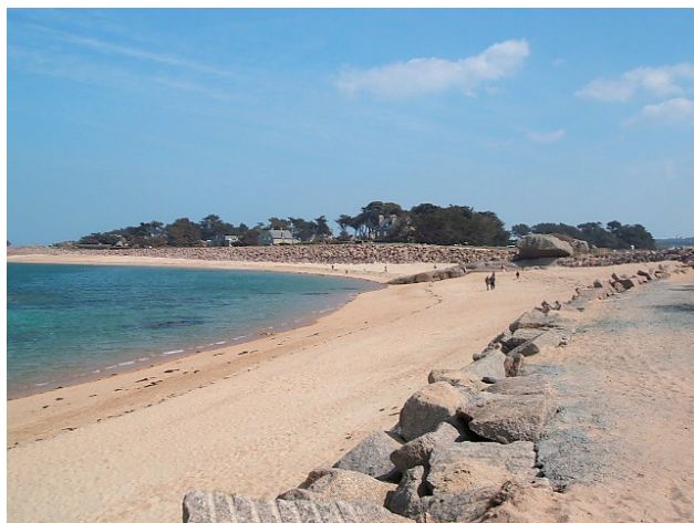
Fig. 6. — Enrochements à Trégastel (22).
