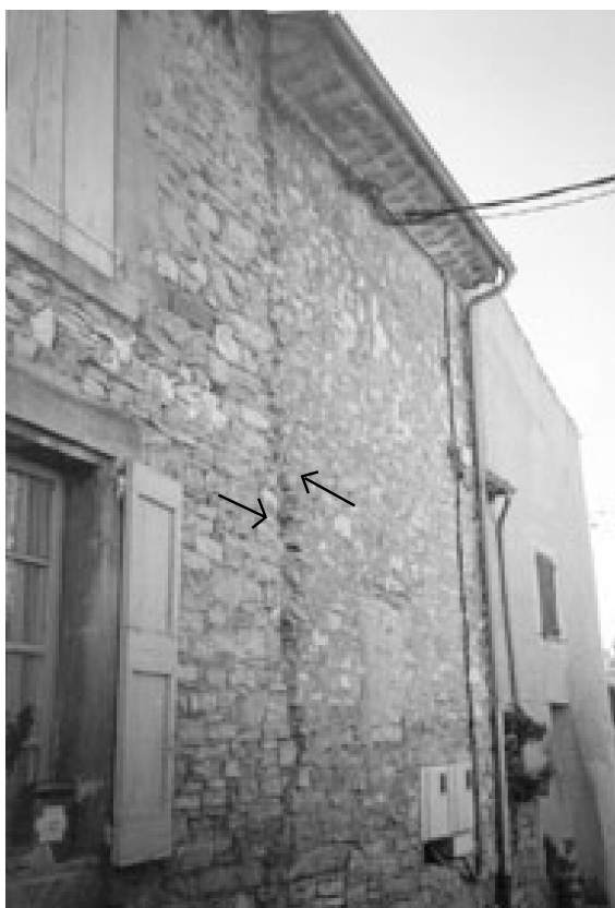
Fig. 6.11 Pelage de façade dans le village de Lincel (photo G. Poursoulis, 2001)
