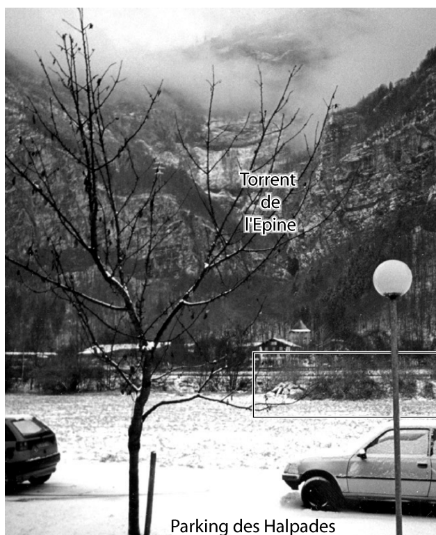
Fig. 2.2 La digue de 1999 délibérément interrompue, vue depuis le parking du bâtiment Halpades I. Magland, janvier 2005. Localisation sur la fig. 2.1 p. 30
