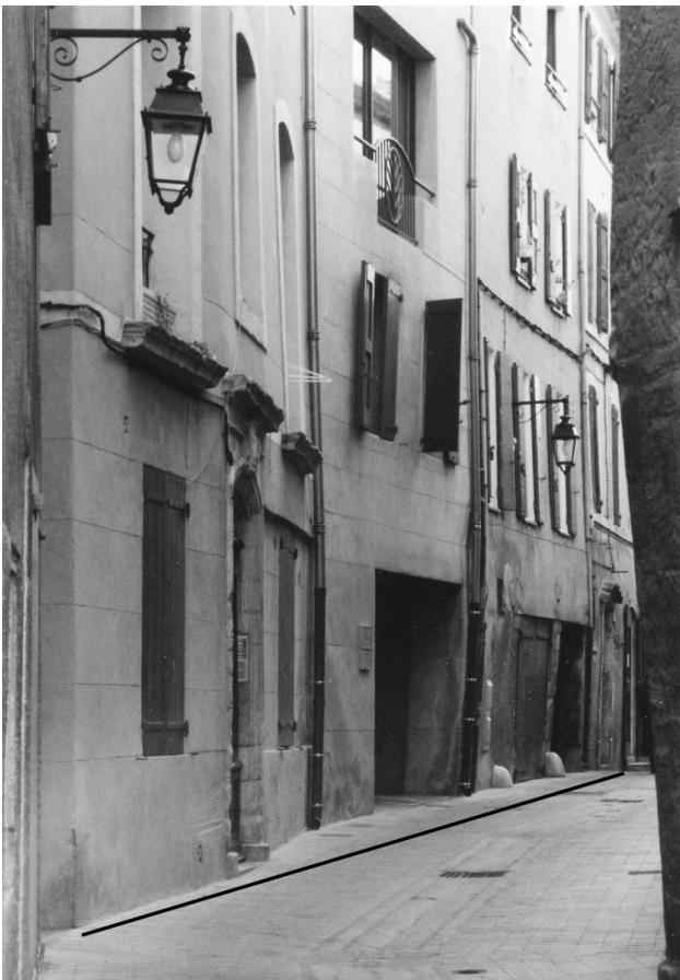
Fig. 6.9 Rupture d'alignement et ondulation des murs d'un îlot de constructions à Manosque (photo G. Poursoulis, 2001)
