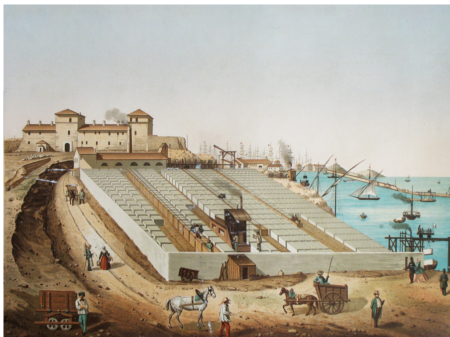
Fig. 1. Le chantier des blocs artificiels pour la jetée du bassin Napoléon de Marseille 52
