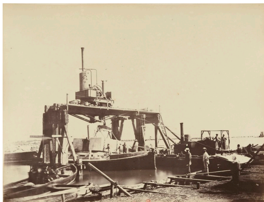
Fig. 2. L'embarquement des blocs avant immersion à Port-Saïd 65
