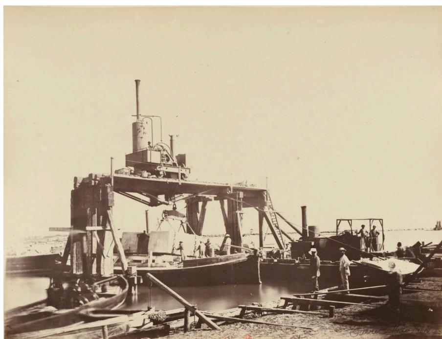
Fig. 2. L'embarquement des blocs avant immersion à Port-Saïd 65
