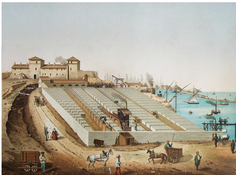
Fig. 1. Le chantier des blocs artificiels pour la jetée du bassin Napoléon de Marseille<sup>52</sup>
