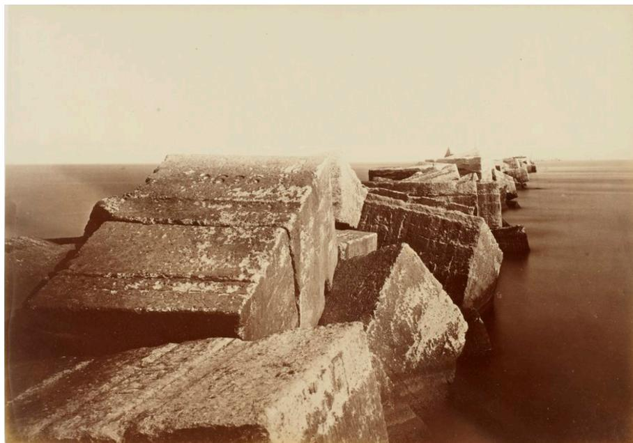
Fig. 3. Blocs artificiels à Port-Saïd<sup>72</sup>
