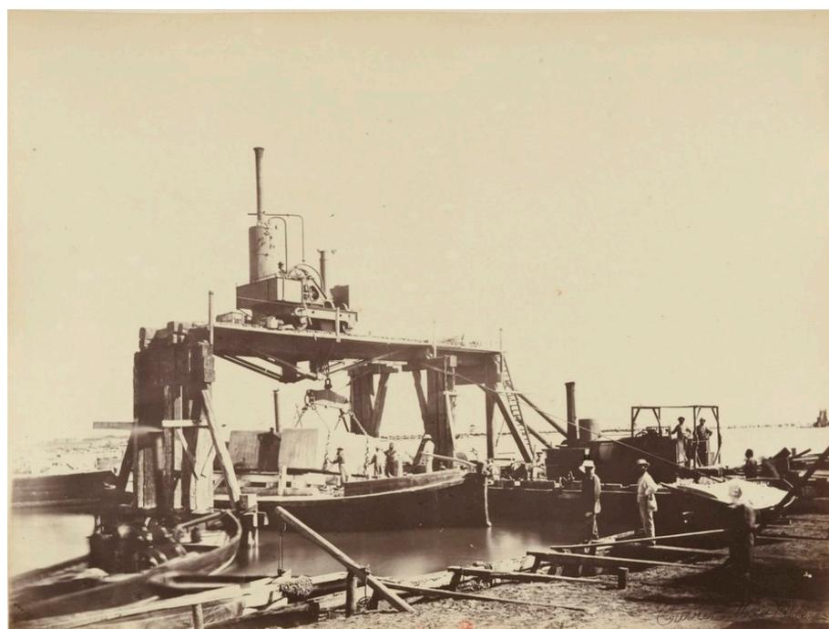
Fig. 2. L'embarquement des blocs avant immersion à Port-Saïd<sup>65</sup>
