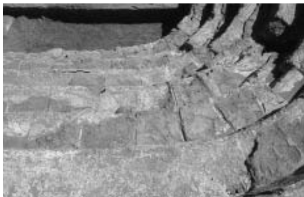
Fig. 4 – Doura-Europos, odéon du temple d'Artémis. Vue des gradins ouest depuis le sommet. On voit des briques cuites, dégradées, qui recouvrent les gradins. Dans la partie droite, les briques sont carrées ( bipedales ), tandis que dans la courbe on a utilisé des briques de forme trapézoïdale (cl. MFSDE).
