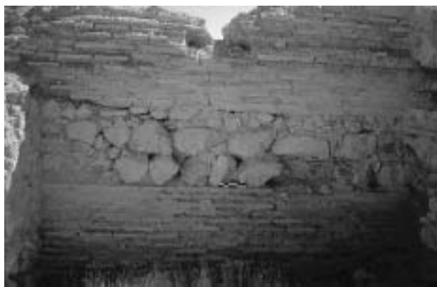
Fig. 2 – Doura-Europos, thermes, îlot F3. Exemple de mur en opus mixtum alternant blocage et assises de briques cuites (cl. MFSDE).
