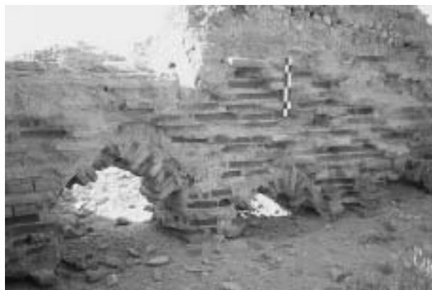
Fig. 3 – Doura-Europos, thermes romains, îlot M7. Utilisation des briques pour la construction d'arcs. Les briques sont placées en position rayonnante (cl. MFSDE).
