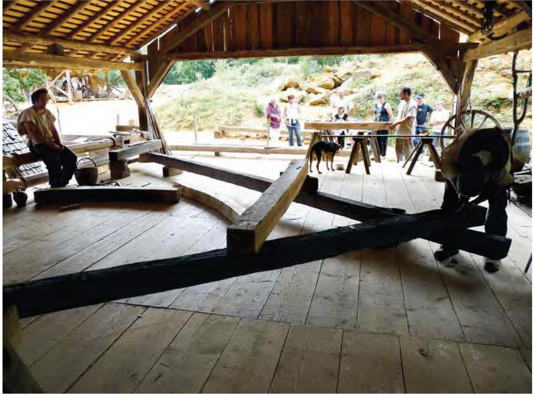
Fig. 6 – Piquage des bois disposés les uns sur les autres suivant les traits de l'épure (cliché F. Épaud).
