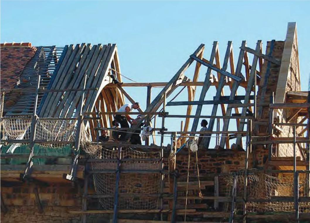
Fig. 9 – Dispositif de la glissière pour mettre en place les fermes de la dernière travée (cliché F. Épaud).
