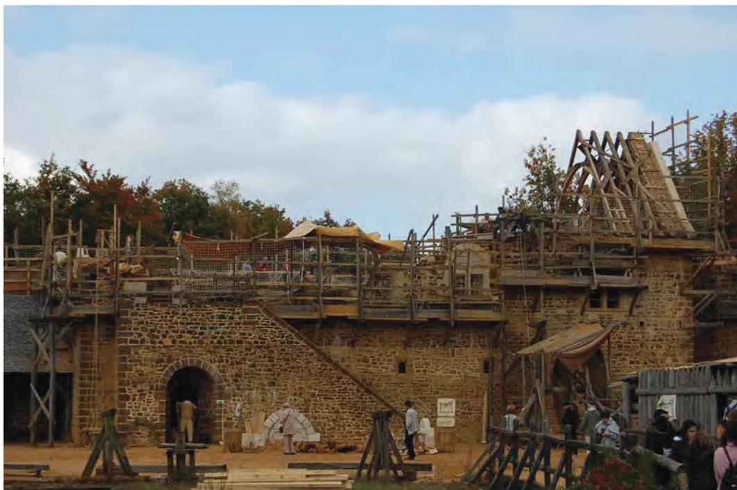
Fig. 1 – Levage de la charpente de la chambre (septembre 2008) [cliché F. Épaul].
