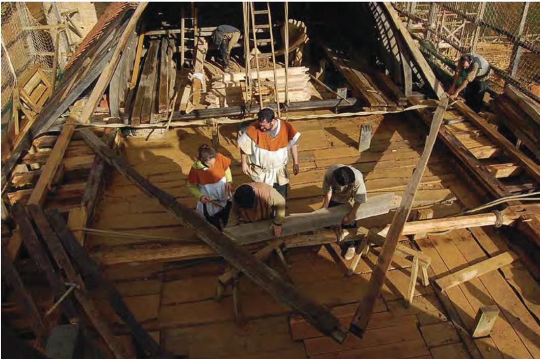
Fig. 7 – Réassemblage d'une ferme sur le plancher de travail (cliché F. Épaud).
