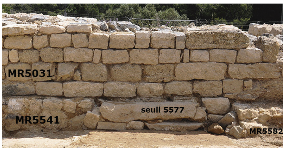
Fig. 78 : vue du seuil SB5577, depuis le nord (Cl. G. Duperron)
