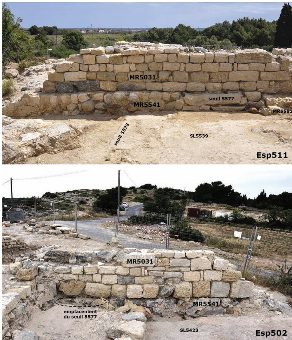
**Fig. 3** : MR5031 et MR5541, parements nord sur le cliché du haut, parements sud sur celui du bas.
