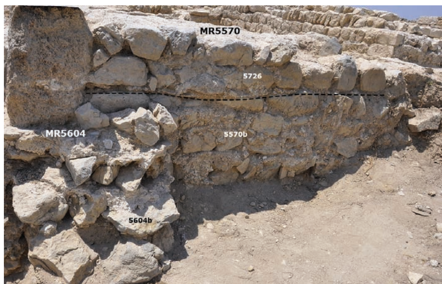
Fig. 27 : Parement oriental de MR5570. On distingue nettement la fondation US5570b de sa reprise de fondation US5726 (©V. Mathieu-CNRS)
