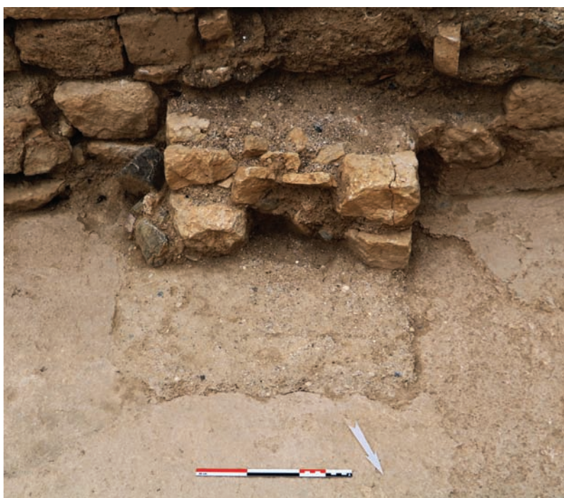
Fig. 76 : vue de la maçonnerie installée dans le sol SL5539 pour construire MR5582 (Cl. G. Duperron)
