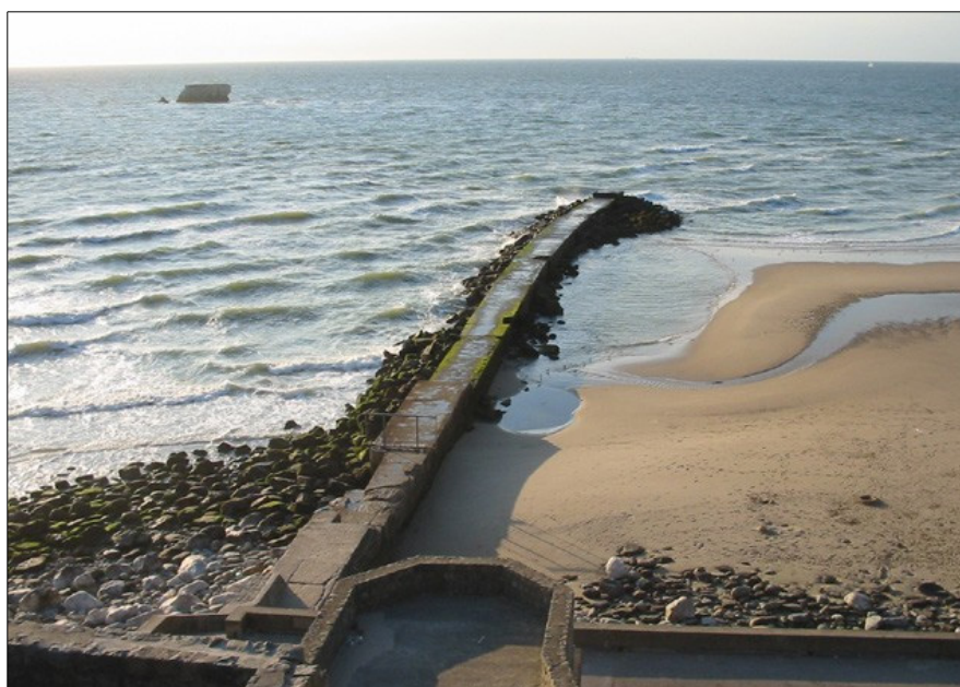
Figure 6.27 : Enrochements de protection du tunage para fouille, visibles le long de l'épi, témoins d'un abaissement de l'estran au sud de la commune du Portel (comleportel.canalblog.com, 2008)
