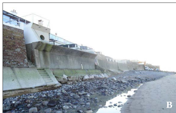
Figure 5.40 : (A) Habitations en arrière de la digue de Sangatte et (B) signes d'abaissement de l'estran et de l'affouillement visibles au niveau des murs de soutènement à l'extrémité sud de la digue de Sangatte suite à la tempête Xaver de décembre 2013 (clichés Egis, pris au cours de l'hiver 2013-2014 ; Egis Ports, ULCO, 2014)
