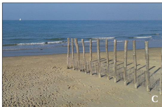
Figure 5.43 : Ensemble des aménagements présents sur la plage des Escardines à Oye-Plage (A, Ruz et al., 2016) ; brise-lames (B) et épi en pieux semi-perméables (C) (clichés Anaïs Daburon, 2015)
