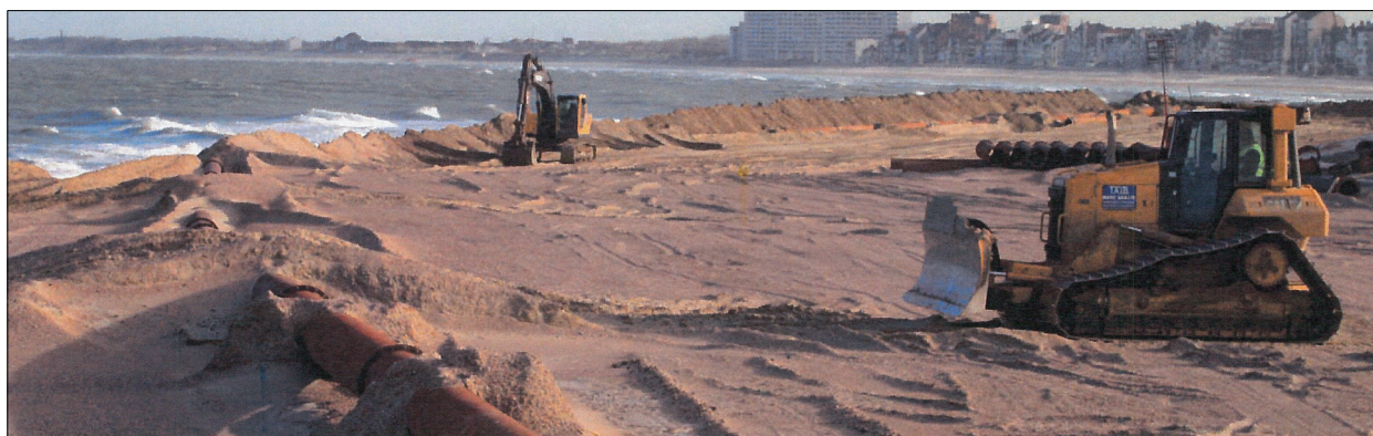
Figure 5.58 : Travaux de ré-ensablement devant la digue des Alliés à Dunkerque (AGUR, 2014)
