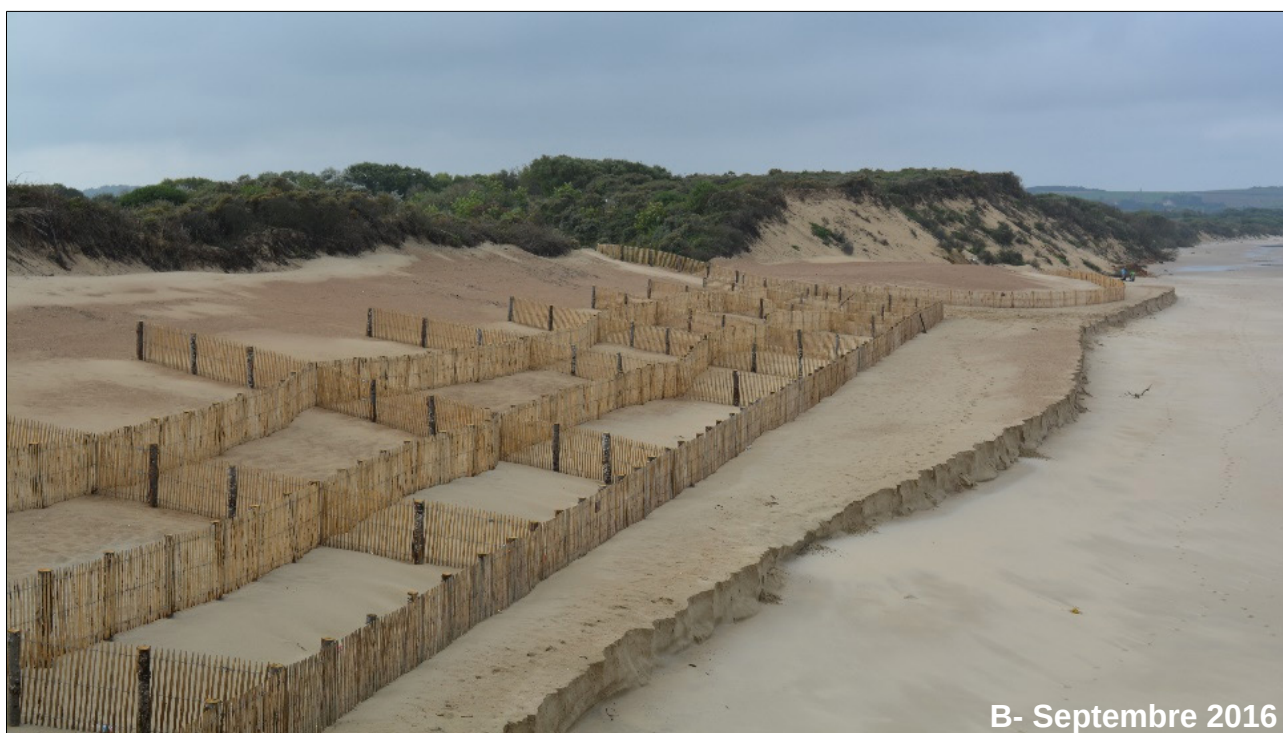
Figure 5.38 : Plage devant la dune d'Aval (A) pendant et (B) après les travaux de rechargement de 50 000 m 3 de sable réalisés en juillet 2016 (clichés Étienne Dubaille et Marie-Hélène Ruz, 2016)
