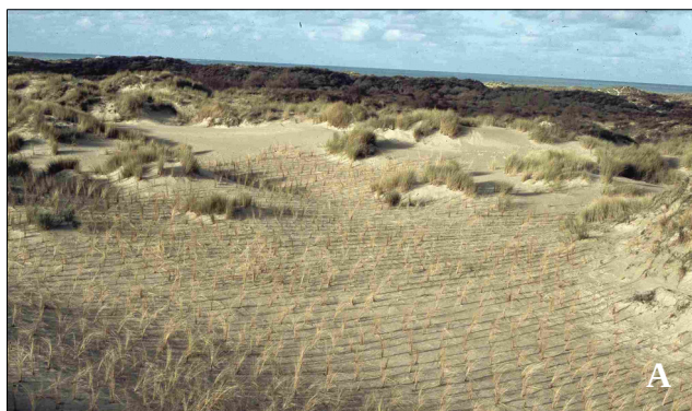
Figure 5.46 : Aménagements souples réalisés dans le massif dunaire est-dunkerquois avec (A) plantation d'oyats et (B) installation de ganivelles (clichés pris par les gardes du littoral, Service des espaces naturels sensibles du Conseil général du Nord, A-1994 et B-1999)
