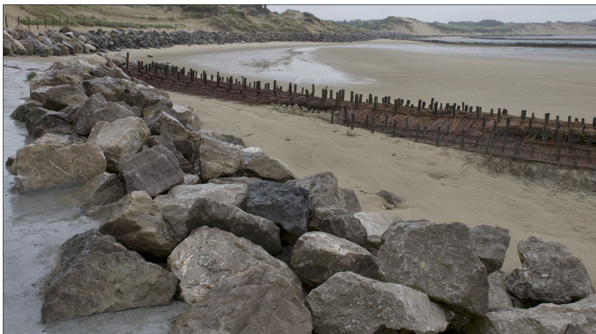
Figure 5.21 : Perré en enrochements au pied du cordon dunaire de l'anse des Stermes (cliché Laurent Mignaux, 2009)
