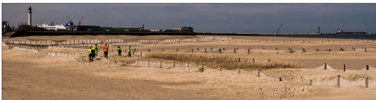
Figure 5.59 : Implantation d'oyats autour des filets brise-vent devant la digue des Alliés (cliché Adrien Cartier, geodunes.fr, 2016b)
