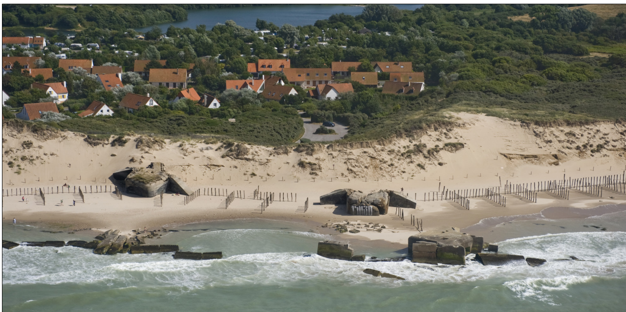
Figure 5.37 : Blockhaus et casiers de pieux en bois présents sur la plage à l'ouest de la commune de Wissant en 2009 (cliché Laurent Mignaux, 2009)
