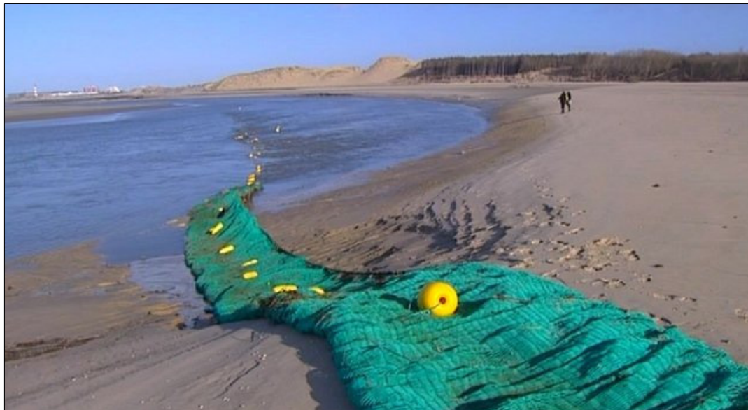
Figure 5.18 : Système de filets piègeurs de sédiments installé en baie d'Authie sur la plage de Groffliers à titre expérimental (@f3nord, 2015)
