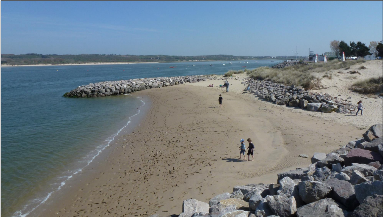
Figure 5.23 : Epis et perré en enrochements sur la pointe du Touquet, en rive gauche de la Canche (cliché Émeric Védie, 2014)
