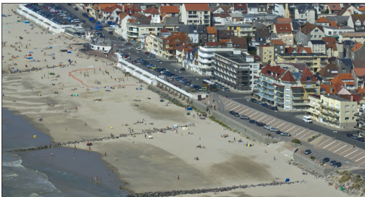
Figure 5.9 : Mur-digue de Merlimont (cliché Laurent Mignaux, 2009)
