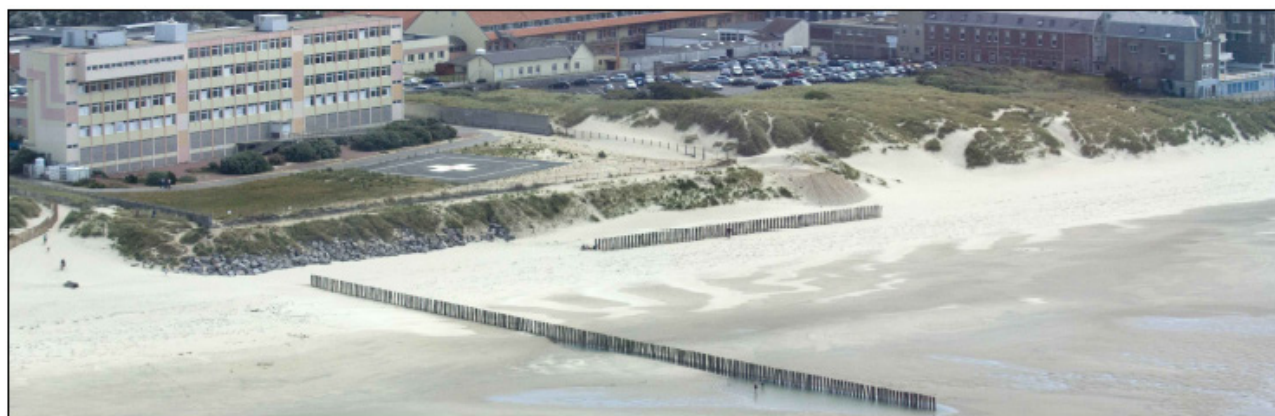
Figure 5.7 : Brise-lames et épi sur l'estran au nord de Berck-sur-Mer (cliché Laurent Mignaux, 2009)
