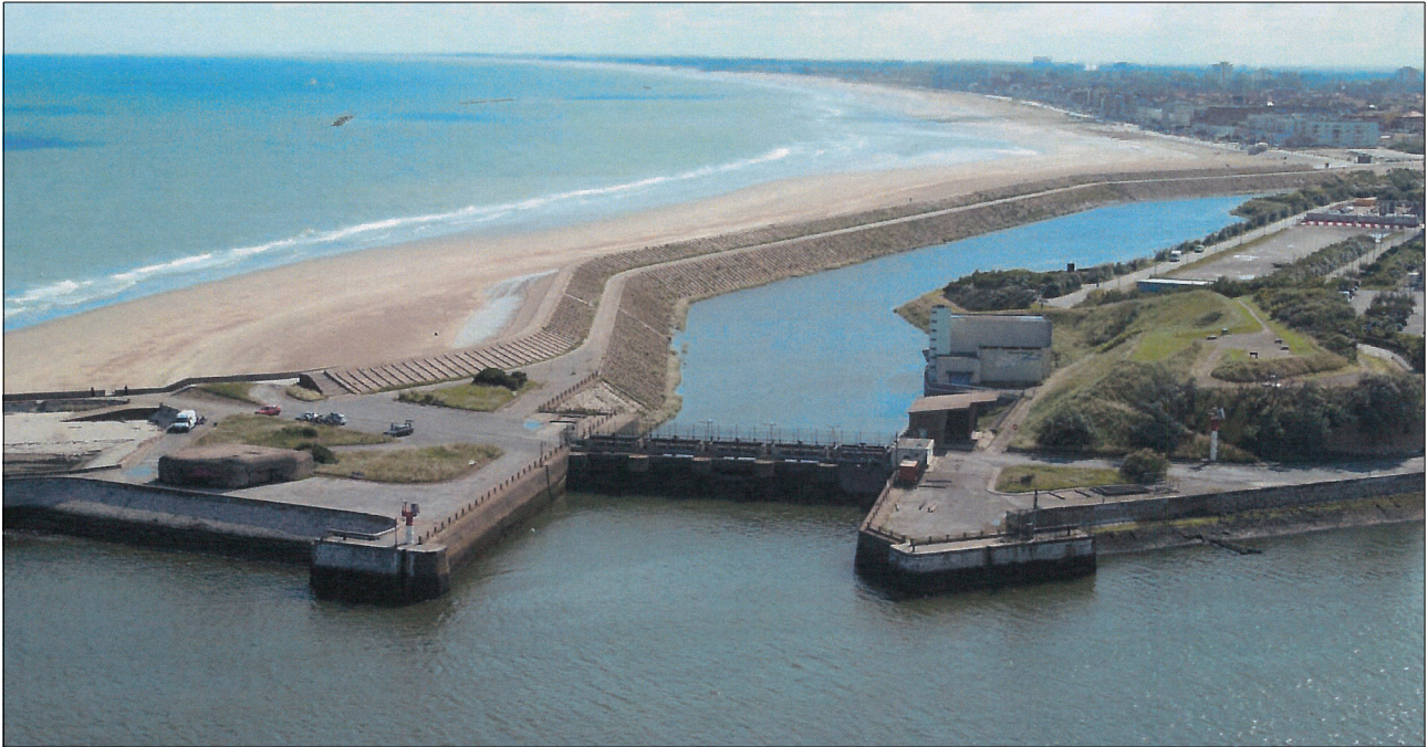
Figure 5.56 : Digue des Alliés et ouvrage Tixier (d'après AGUR, 2014, cliché IIW)
