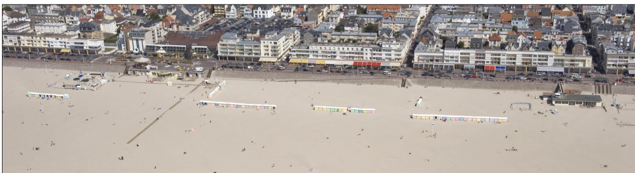
Figure 5.6 : Digue-promenade de la plage centrale de Berck-sur-Mer (cliché Laurent Mignaux, 2009)
