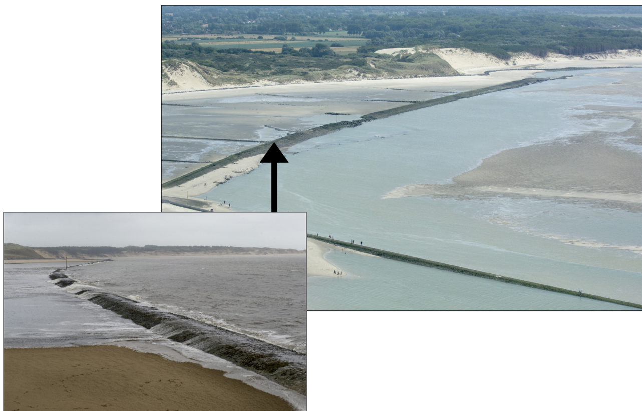
Figure 5.19 : Digue submersible et épis présents dans l'anse des Sernes, au nord de la baie d'Authie (clichés Laurent Mignaux, 2009)
