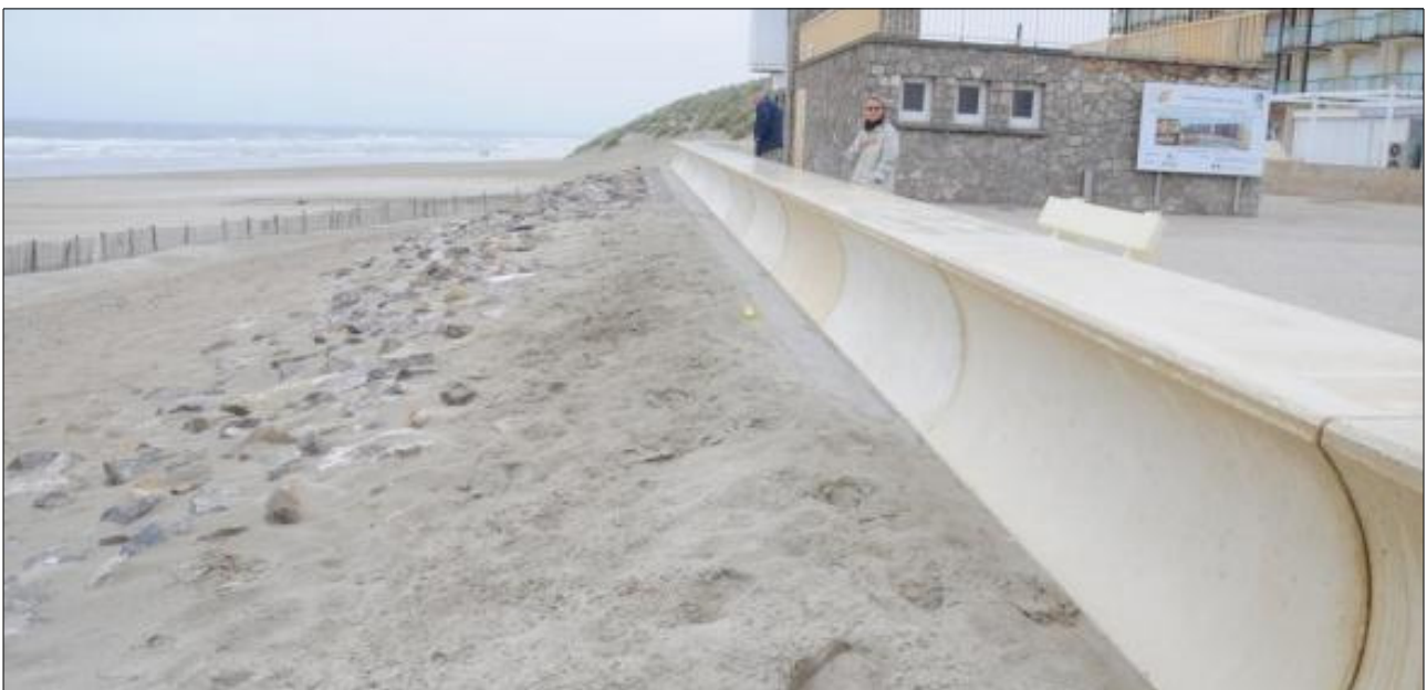
Figure 5.13 : Perré en partie ensablé et mur anti-sable et pare-vagues du front de mer de Sainte-Cécile-Plage à Camiers (La Voix du Nord, Chiari, 2013)
