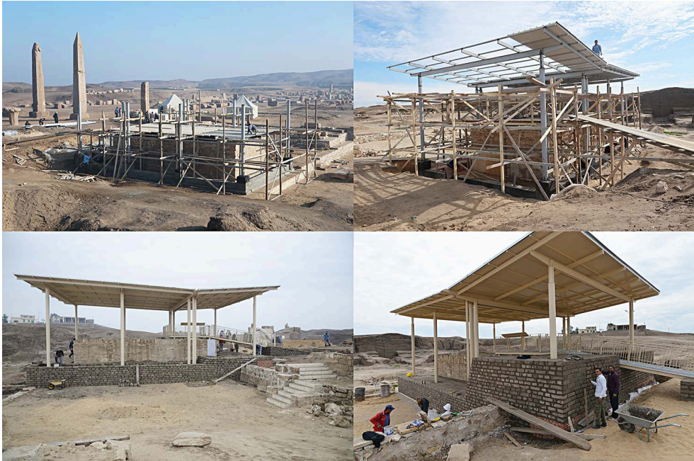
Fig. 4. Le nouvel abri de la tombe de Chéchonq III en cours de construction (Fr. Leclère, P. Le Guilloux).
