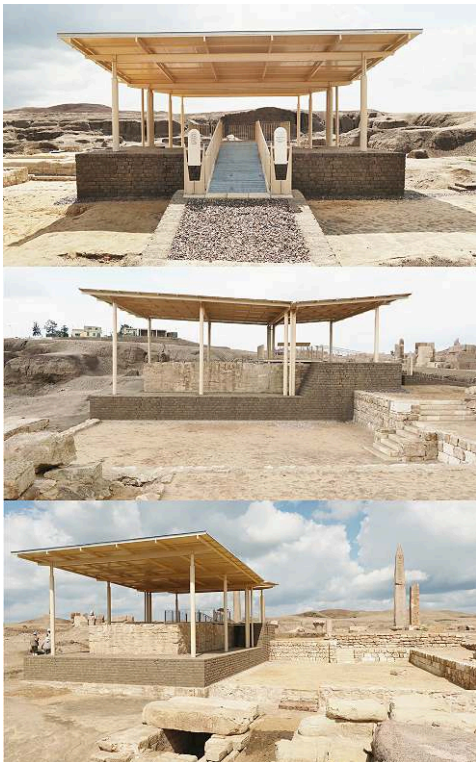
Fig. 5. Le nouvel abri de la tombe de Chéchonq III en cours de finalisation (Fr. Leclère).
