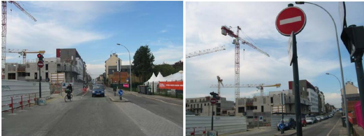
Rue de l'Alma, en travaux (et « caravane des quartiers »)
