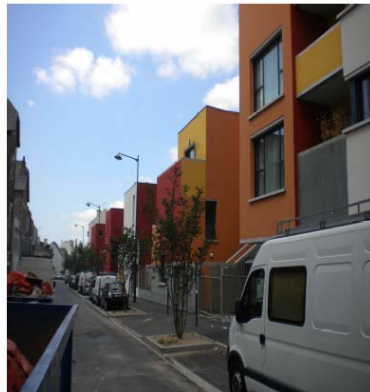
Photo 2 : premiers logements de la ZAC Alma.
