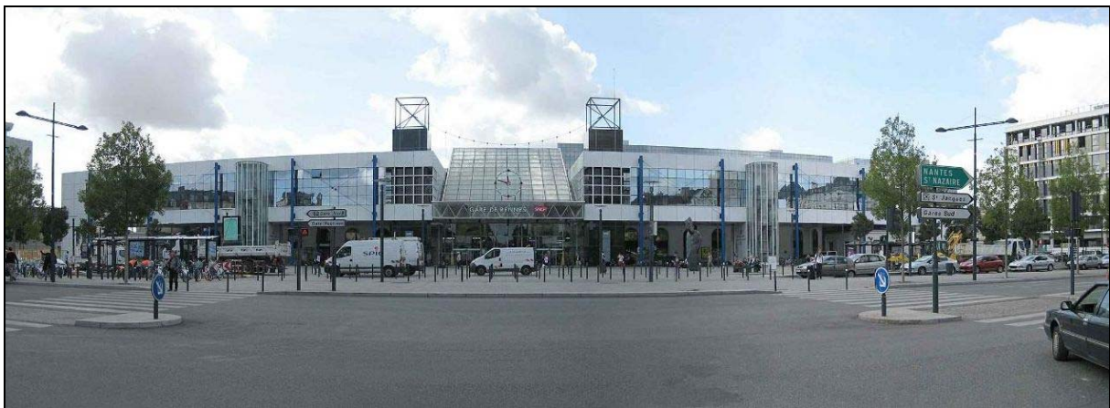
Figure : gare actuelle, vue Nord
