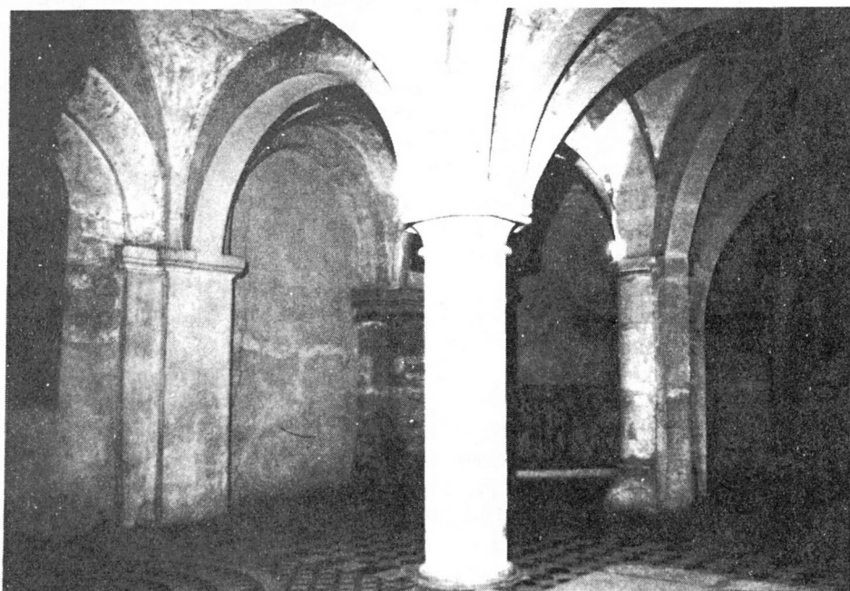
b - Collatéral nord (vu du S.W.).
