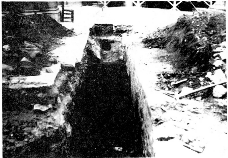
b - Mur roman, conduit d'évacuation des eaux, 4ème travée (vu du nord) (cl. Agence des Bâtiments de France de la Moselle).
