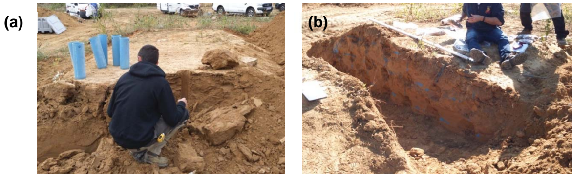
Figure 4. (a) Tentative de récupération d'échantillon intact par fonçage de tube PVC et (b) échantillonnage sur un profil en travers de la digue en sol limoneux non traité.
