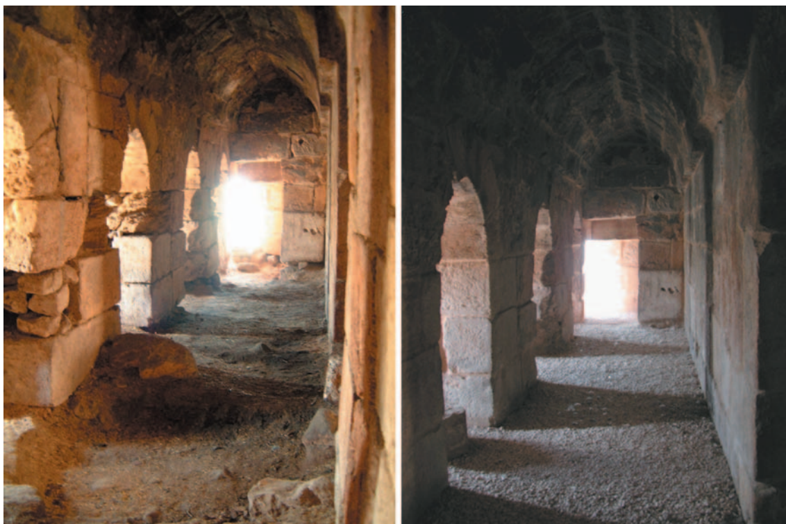
Fig. 19 - Tour 5, salle 2, vers le sud. À gauche, avant travaux, à droite, après.
