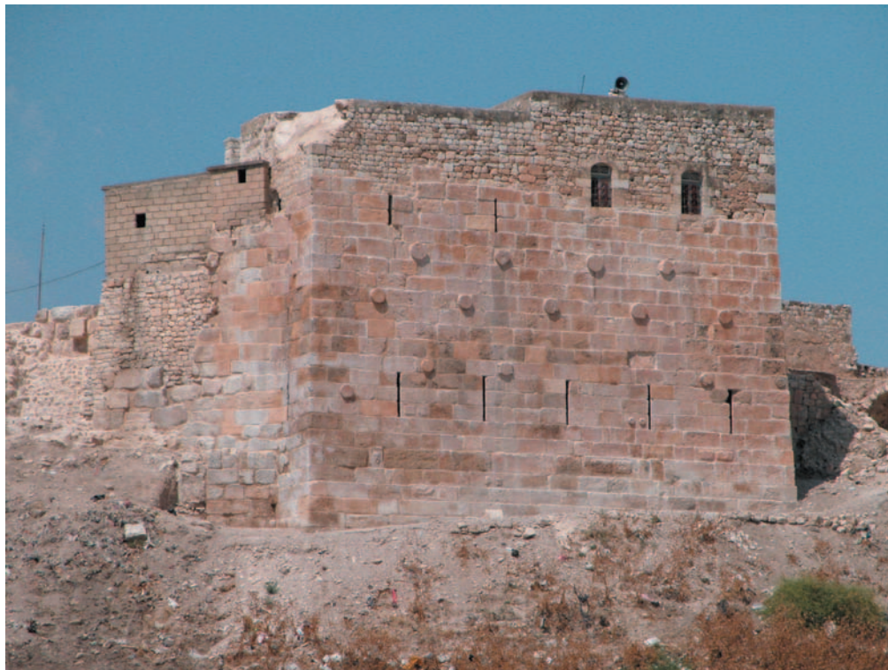
Fig. 20 - Tour 5, vue générale de la façade orientale à la fin des travaux.
