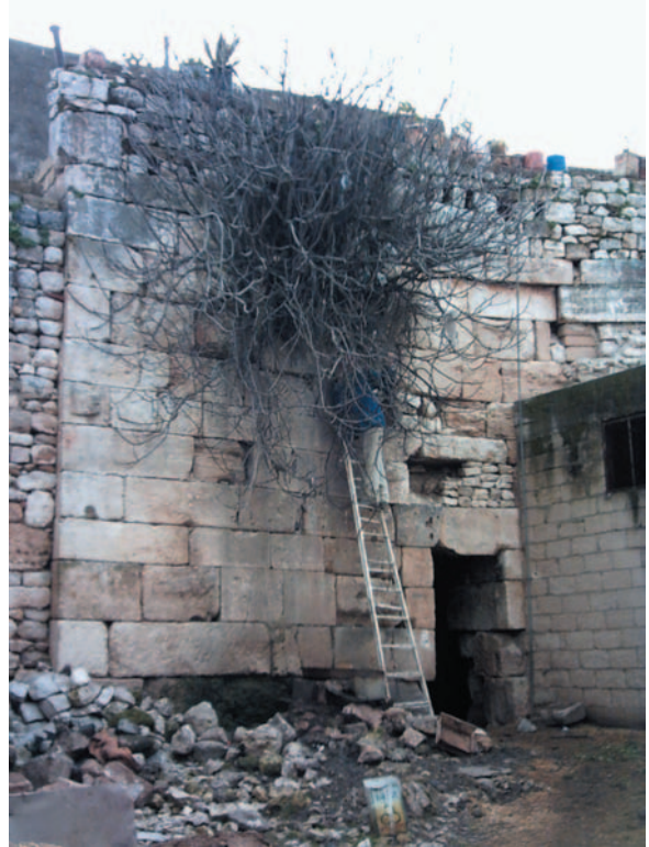
Fig. 17 - Tour 5, façade occidentale (partie nord) avant travaux.
