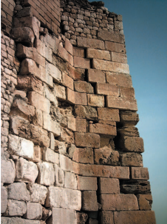
Fig. 16 - Tour 5, façade méridionale avant travaux.
