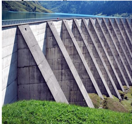
Exemple de barrage de rétention
