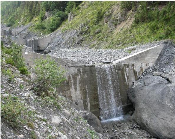
Fig. 1. Barrages de correction torrentiels. Bassin versant de Saint Antoine, France, 2014 (Source : INRAE, Unité de recherche ETNA).
